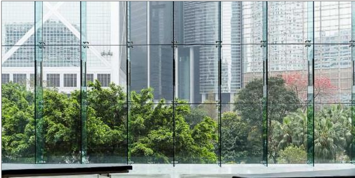
Figura 182 Panel de muro cortina
