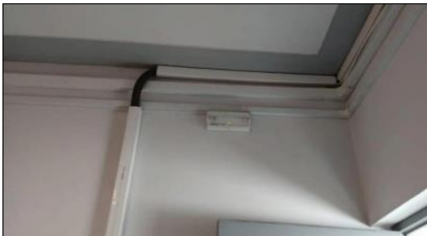
Figura 100 Luces de emergencia en las oficinas.
