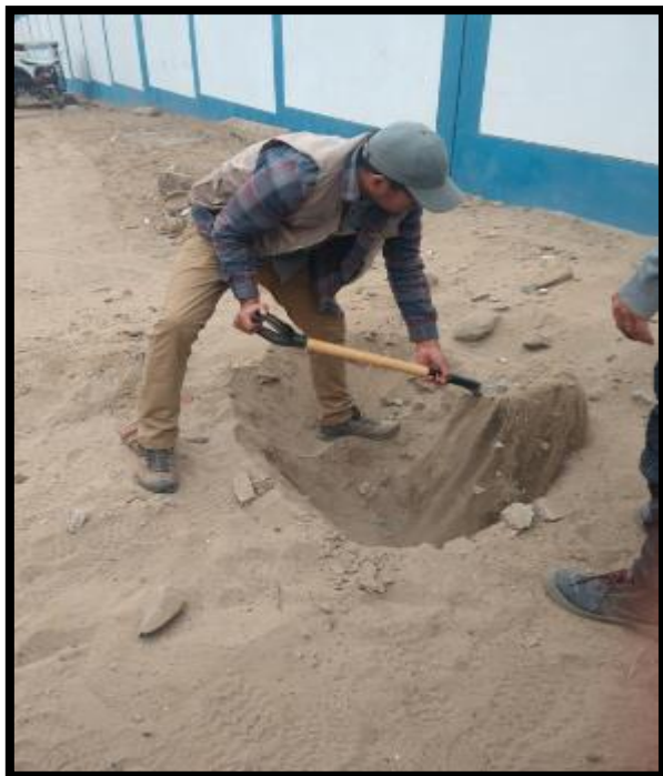
Excavación de forma manual.
