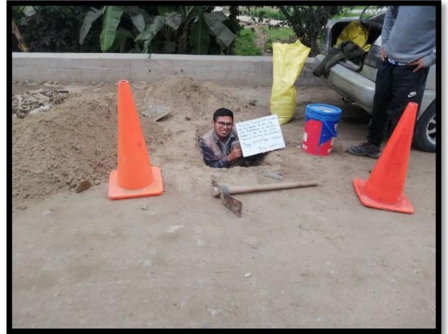
Verificación de profundidad de calicata
