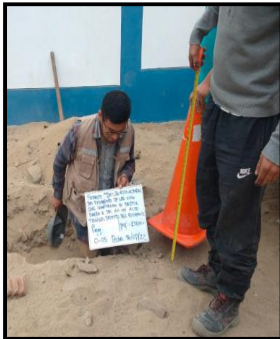
Verificación de la profundidad.
