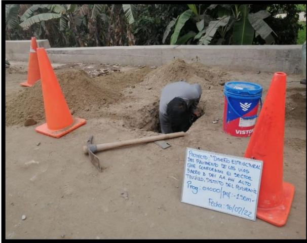
Excavación de forma manual.
