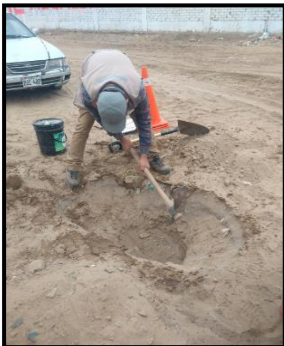
Inicio de excavación de forma manual
