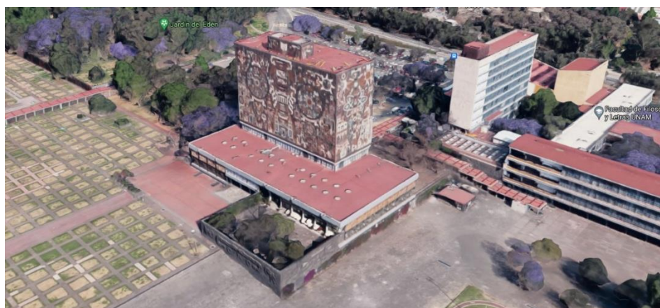
Figura N° 80: Vista aérea del campus de la UNAM
