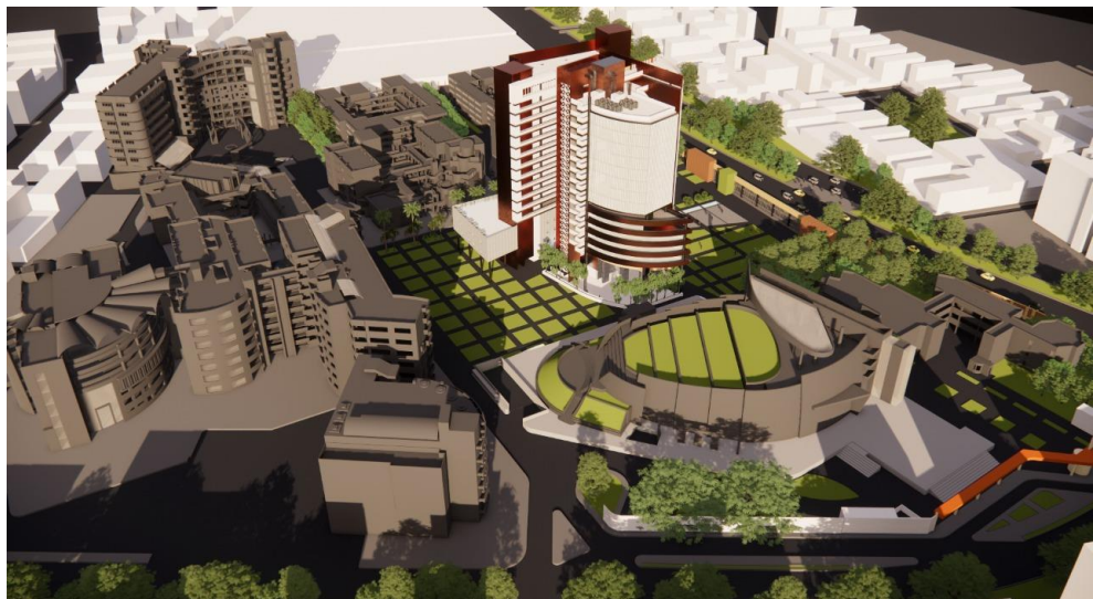
Figura N° 40: VISTA AÉREA POSTERIOR DE LA TORRE
