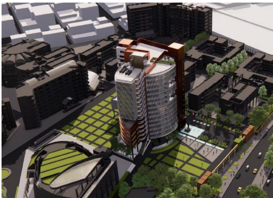
Figura N° 51: VISTA AÉREA DE LA TORRE DESDE EL NOR OESTE.
