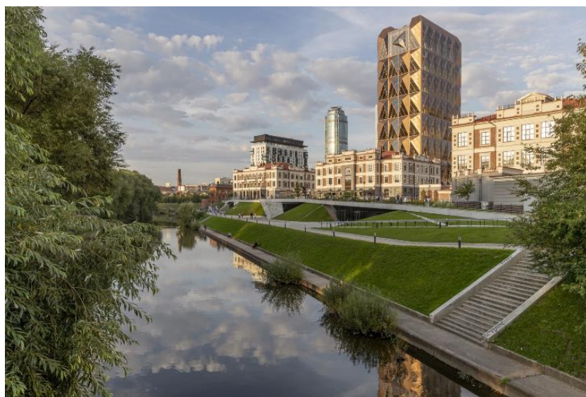
Figura N° 84: Vista externa de la torre Sede de RCC
