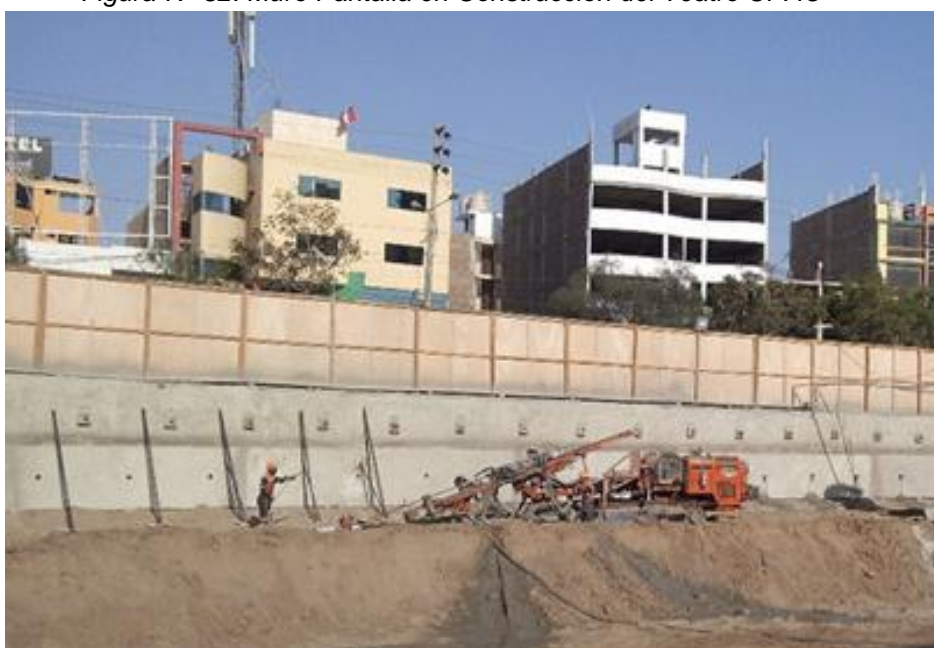
Figura N° 52: Muro Pantalla en Construcción del Teatro UPAO
