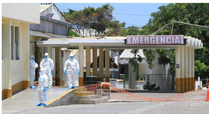
Figura 06: Unidad de Emergencia del Hospital Regional de Trujillo
