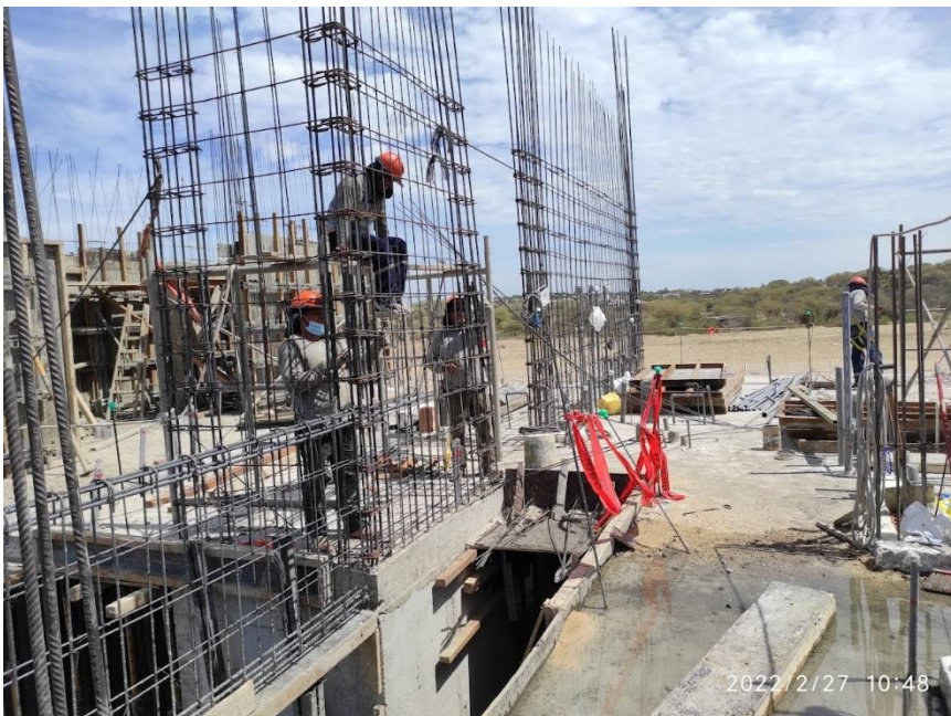
Tejido y encofrado de verticales sector 2 encofrado de verticales en el sector 1 del nivel 3 edificio Algarrobos
