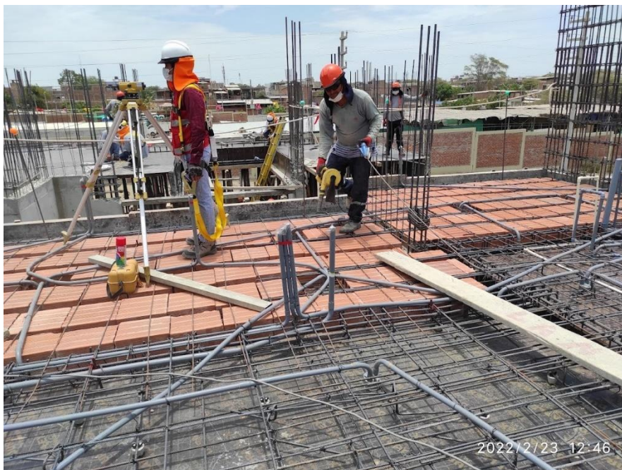
Control de niveles en losa sector 1 y 2 para nivel 3 edificio Algarrobos
