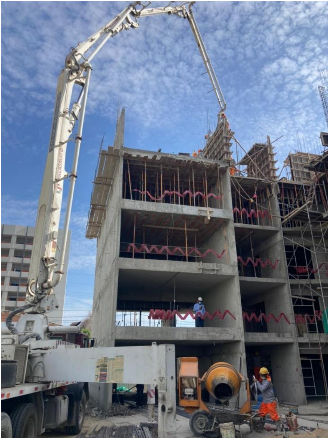
Llenado de placas sector 1 y 2 edificio Poncianas
