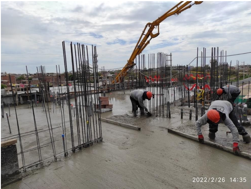
Llenado de losas sector 1 y 2 para nivel 3 edificio Algarrobos
