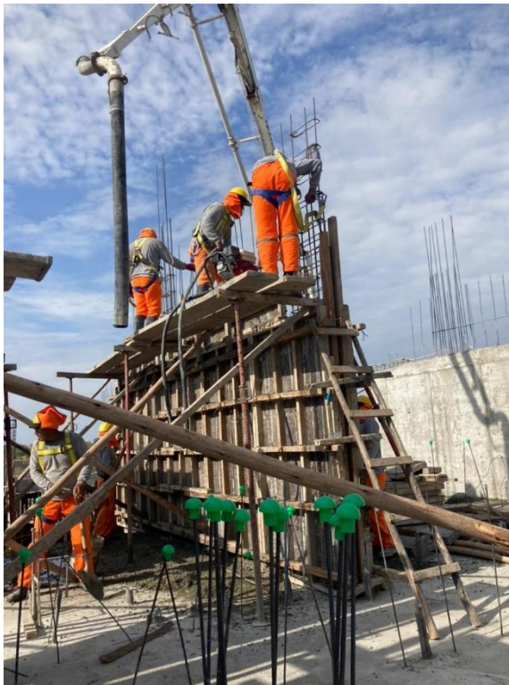
Llenado de placas sector 1 y 2 para nivel 4 edificio Poncianas
