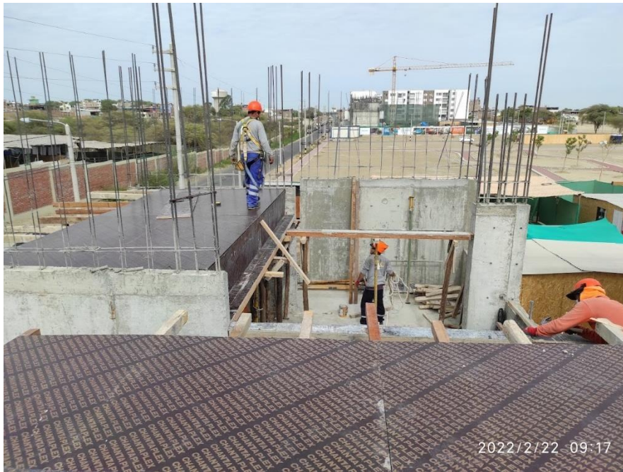
Encofrado de Losa sector 3 y 4 para nivel 3 edificio Algarrobos
