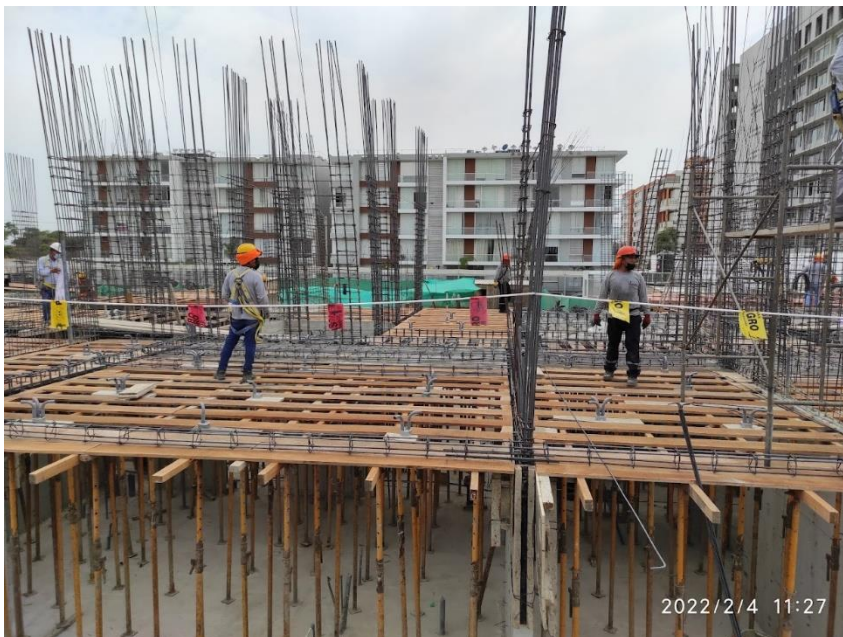
Tejido de Verticales y Encofrado Horizontal sector 2 y 3 de edificio Poncianas
