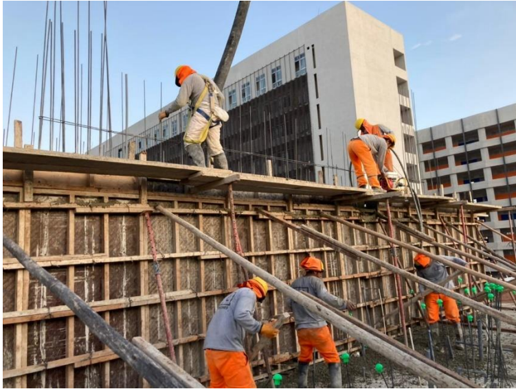
Llenado de placas sector 1 y 2 para nivel 4 edificio Poncianas
