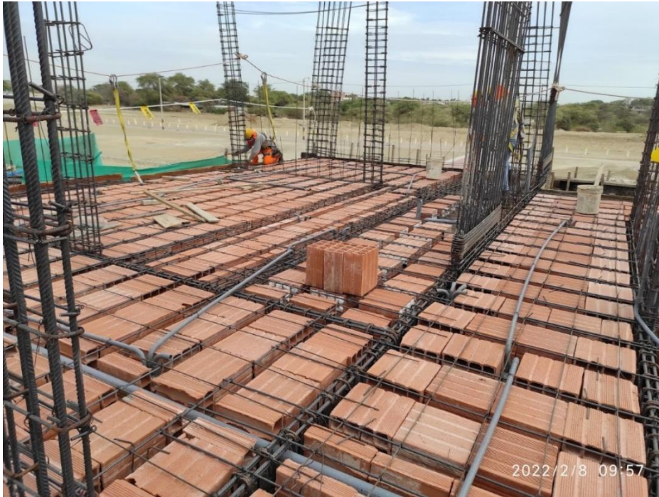
Emplantillado de Ladrillos sector 3 de edificio Poncianas
