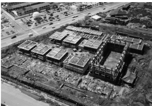
Imagen N°02: Vista aérea de proyecto en construcción
