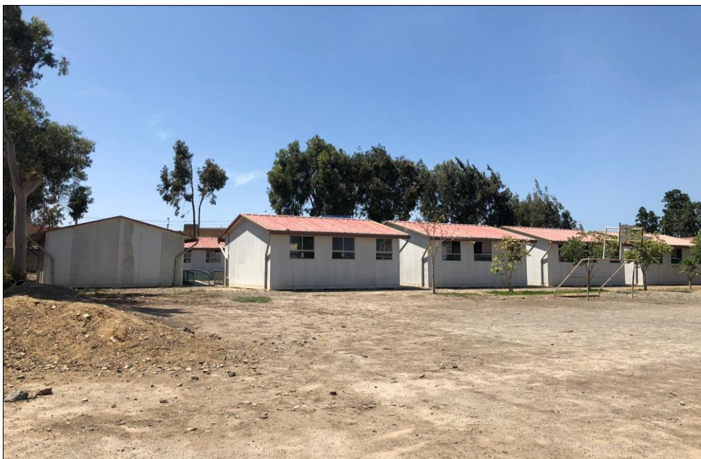
Figura N° 16: Fotografía donde se observa los módulos de aulas instalados en el año 2016, actualmente siguen en buenas condiciones, pero siendo una construcción temporal, quedó permanente debido a la necesidad y la poca ayuda del Estado.
