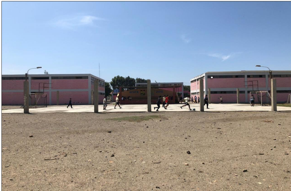
Figura N° 20: Fotografía de las losas deportivas de uso diario que no tiene la cubierta superior cuya función es proteger de los rayos del sol, una muestra que no existe preocupación por parte del estado para el acondicionamiento de los espacios.
