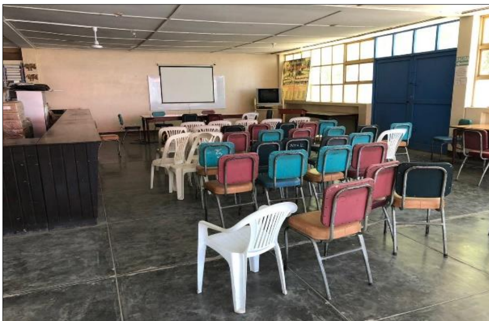
Figura N° 21: Fotografía del ambiente de la Biblioteca tiene un área de proyección que cuenta con un cielo raso deficiente, el equipamiento y mobiliario son obsoletos y por último el cableado eléctrico en varias partes se encuentra expuesto.
