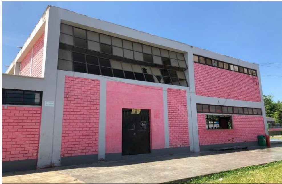
Figura N° 11: Fotografía del taller de mecánica y electricidad, actualmente se usa dos veces por semana, ya que la infraestructura del exterior e interior se encuentra en muy mal estado, mientras que el mobiliario se encuentra en buenas condiciones.
