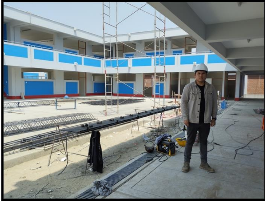
Verificación de termino de estructura
