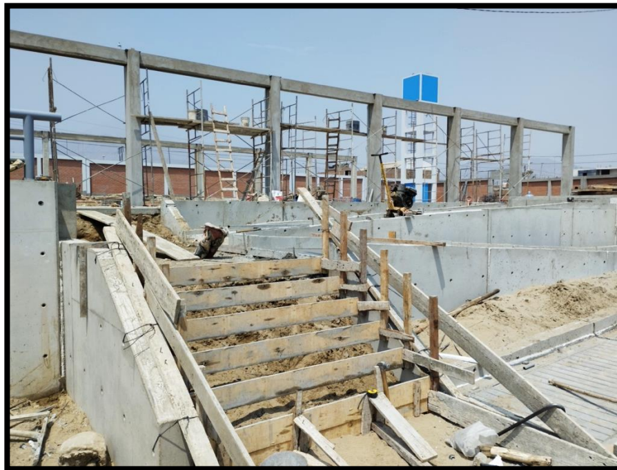
Observación de rendimiento de mano de obra, maquinaria, construcción de pórtico destinado al ambiente del coliseo
