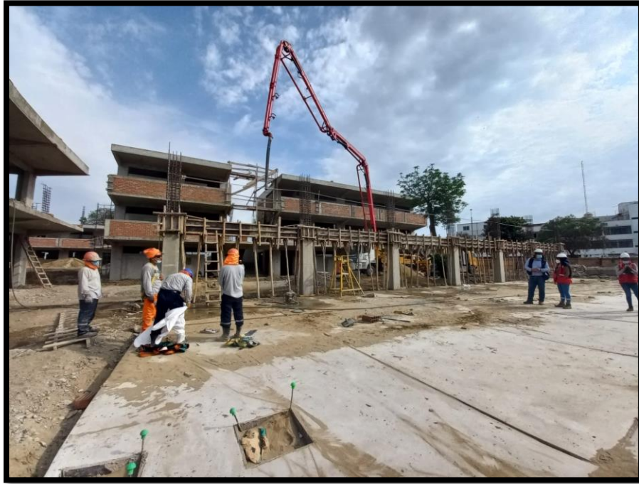
Observación de rendimiento de mano de obra, maquinaria, vaciado de concreto en losa aligerada, se aprecia que se usaron diferentes tecnologías para el concreto armado
