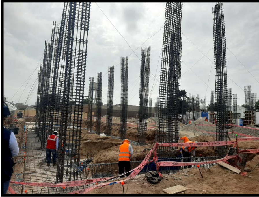
Observación de rendimiento de mano de obra en concreto armado (columnas y armado de vigas de cimentación)
