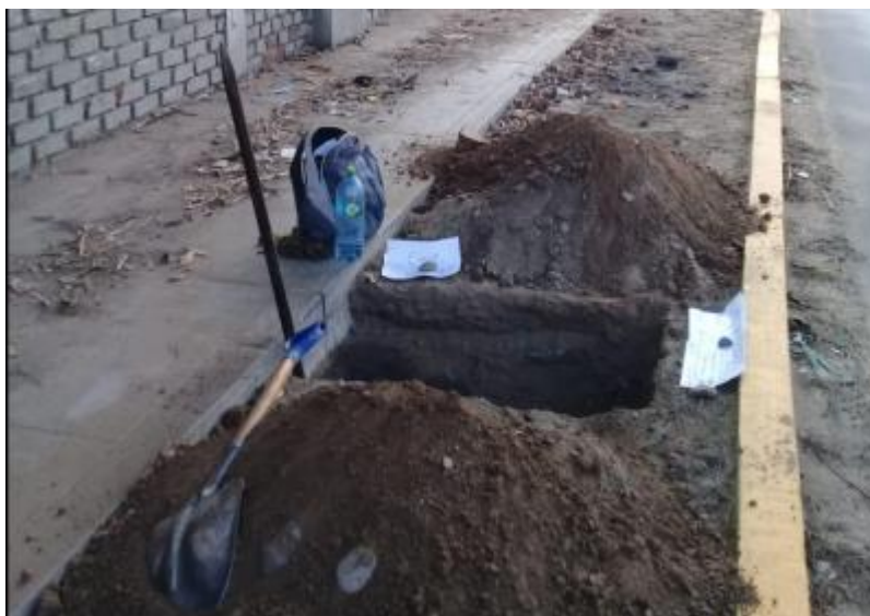
Vista de la calicata C-3 , nótese en la superficie el material de relleno conformado suelo orgánico, arena y algunas piedras. A continuación, se encontró un estrato de Arenas pobremente graduadas con pocos limos ( SP-SM ), de color beige pardo a amarillo claro, de consistencia media y regular humedad. No se encontró el Nivel de aguas freáticas (NAF).
