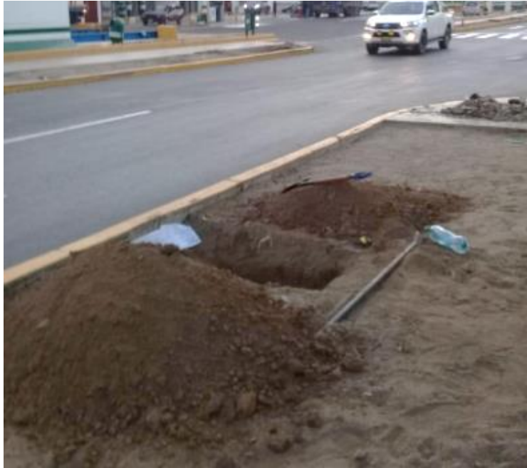
Vista de la calicata C-4 , nótese en la superficie el material de relleno conformado suelo orgánico, arena y algunas piedras. A continuación, se encontró un estrato de Arenas arcillosas ( SC ) de color marrón claro, de consistencia media y regular humedad. No se encontró el Nivel de aguas freáticas (NAF).
