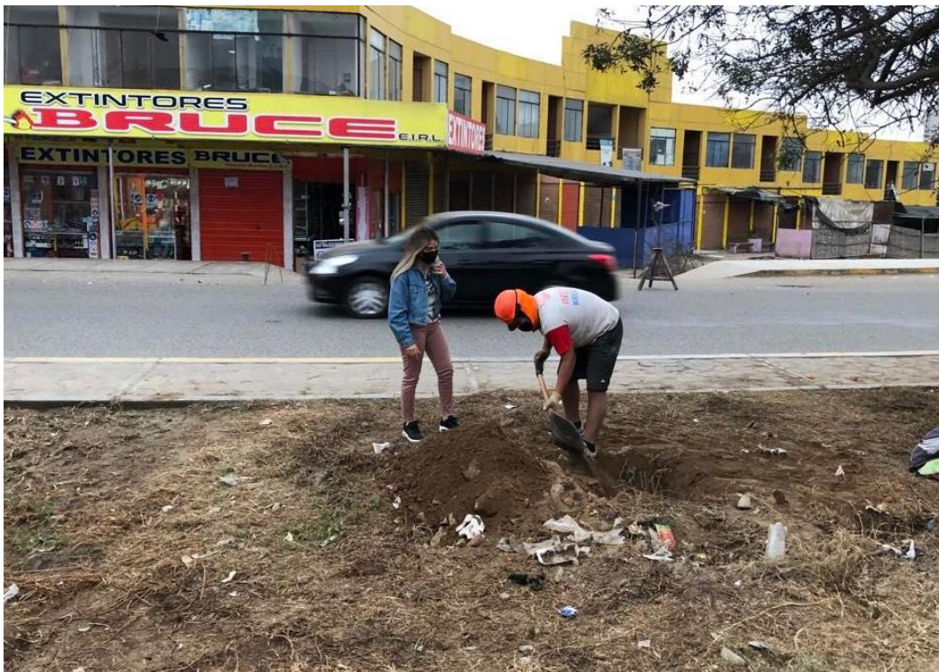
Excavación de calicata en la zona de estudio
