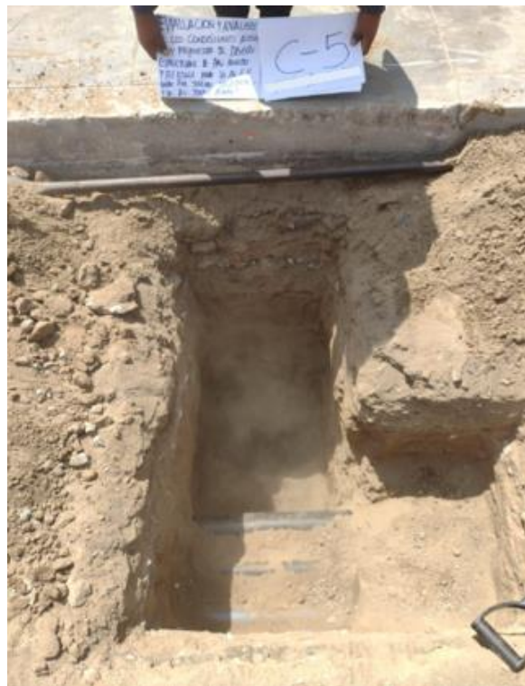
Vista del perfil estratigráfico de la calicata C-5 , nótese en la superficie el material de relleno conformado suelo orgánico, arena y algunas piedras. A continuación, se encontró un estrato de Arenas pobremente graduadas con pocos limos ( SP-SM ), de color beige pardo a amarillo claro, de consistencia media y regular humedad. No se encontró el Nivel de aguas freáticas (NAF).
