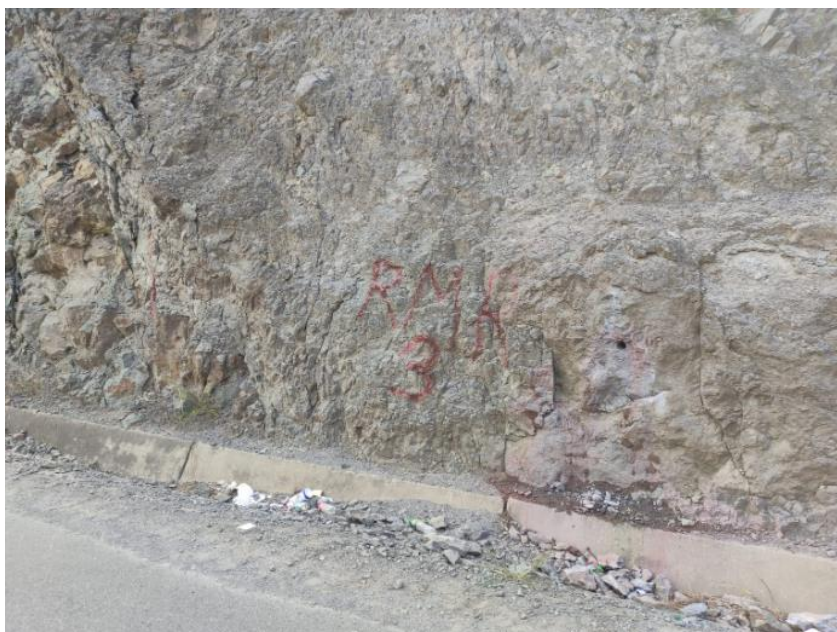
Figura 56 Identificación del tramo n° 3
