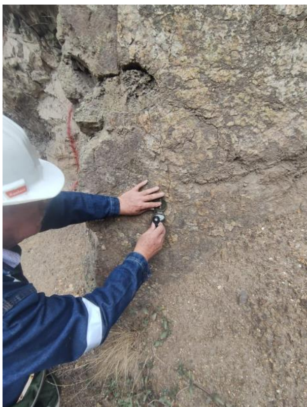
Figura 65 Orientación y buzamiento de las discontinuidades
