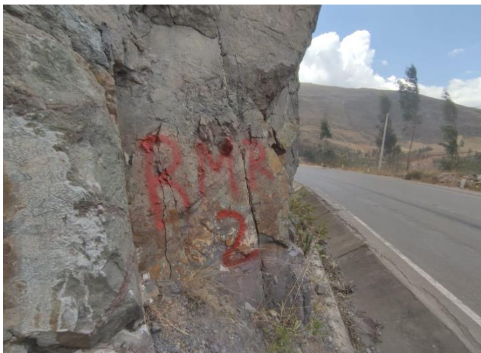
Figura 52 Identificación tramo n° 2
