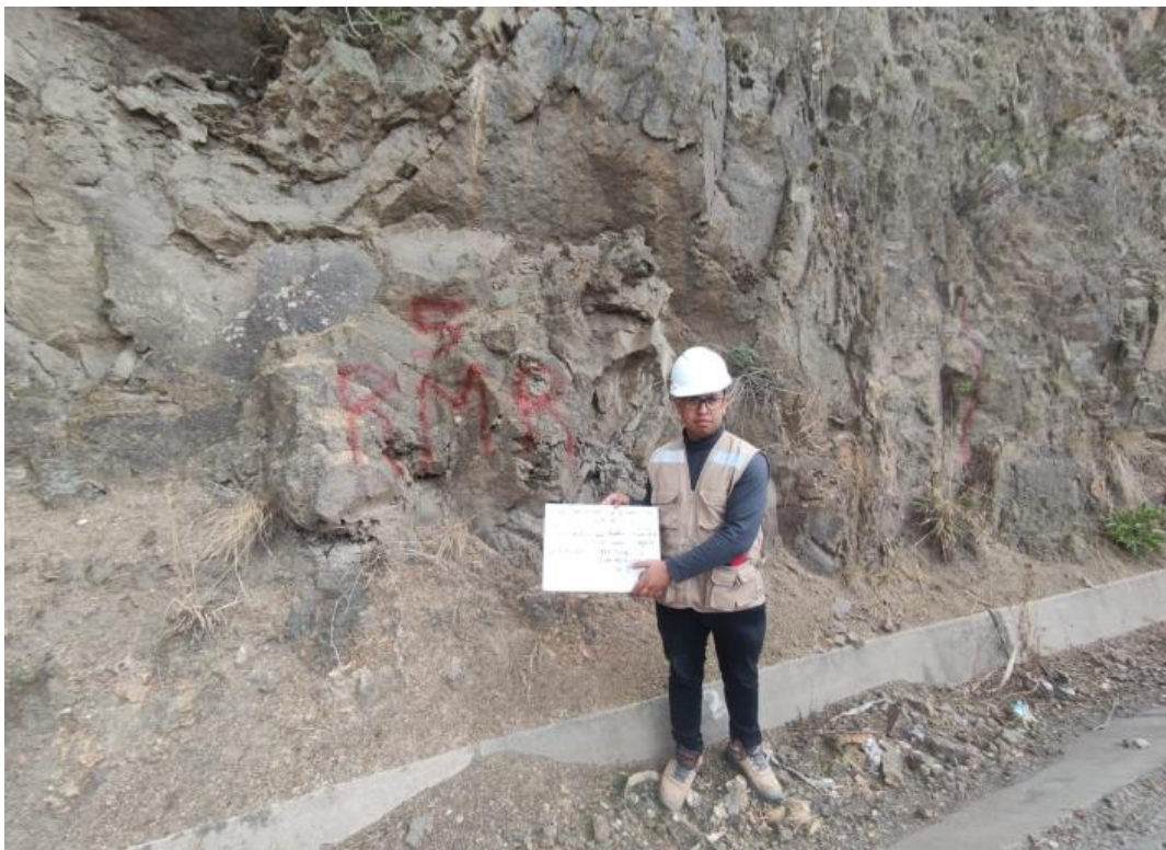
Figura 64 Identificación tramo n° 5
