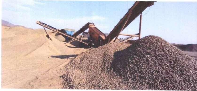
Figura N° 7: Chancadora y faja transportadora de la cantera Chicama
