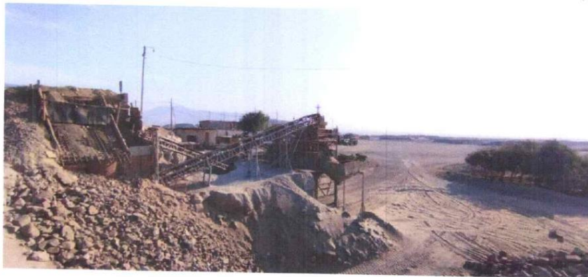
Figura N° 6: Chancadora y tamizadora de la cantera Chicama
