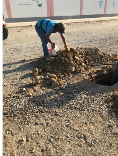
**Figura 25:** *Excavación de calicatas*
