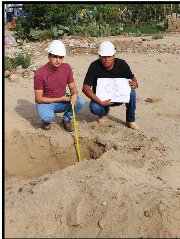
Foto 9. Excavación de Calicata 02
