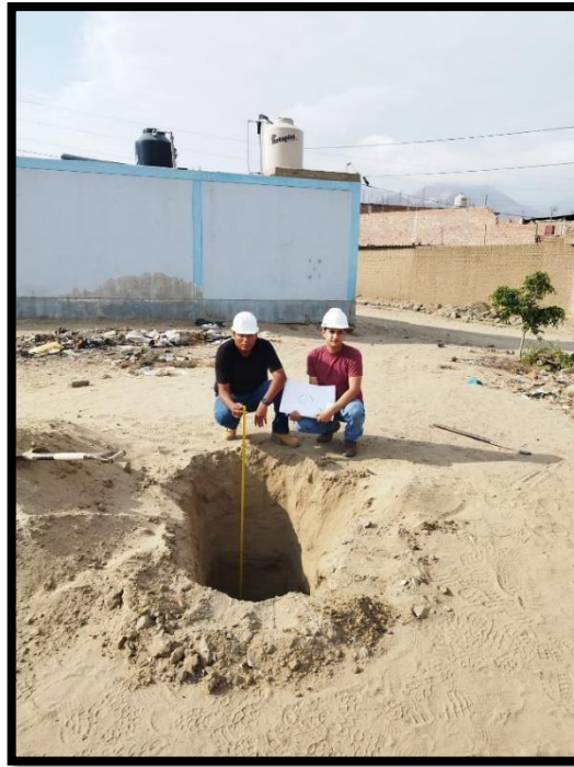
Foto 8. Excavación De Calicata 01
