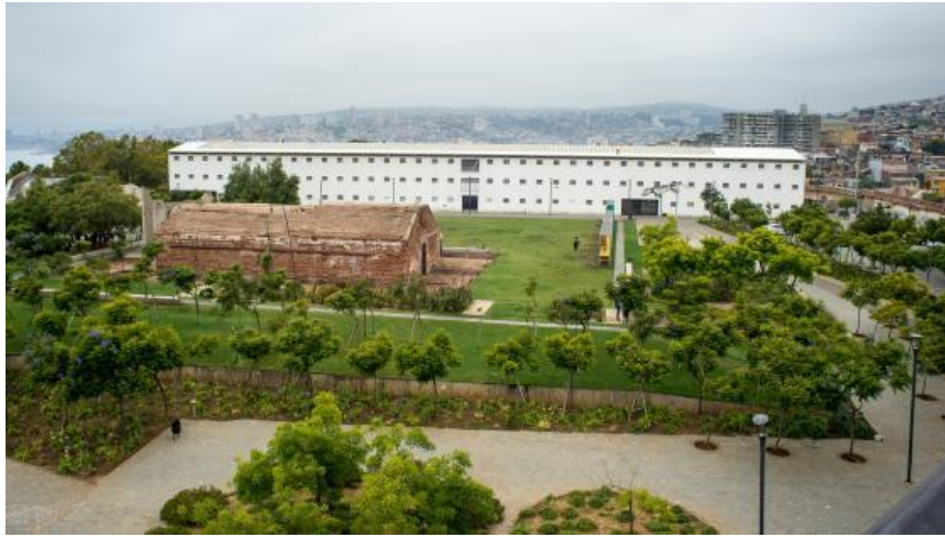
Figura 48: Vista del Proyecto
