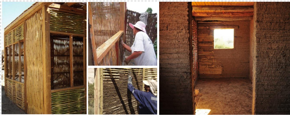
Imagen N° 104: Sistema de paneles de quincha mejorada
