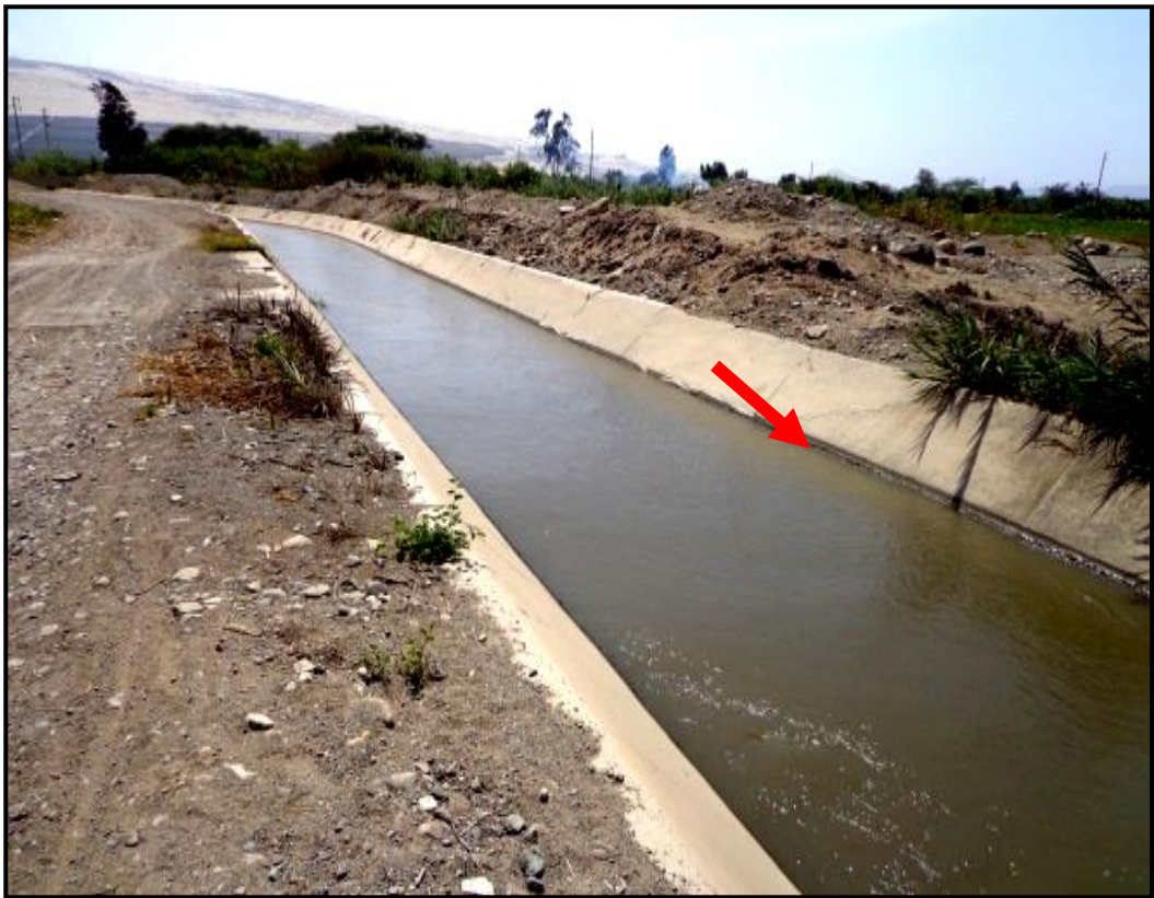
Figura 12. Marca uniforme del pelo de agua en la pared lateral del canal Chavimochic sin formación de olas. Fuente Propia.
