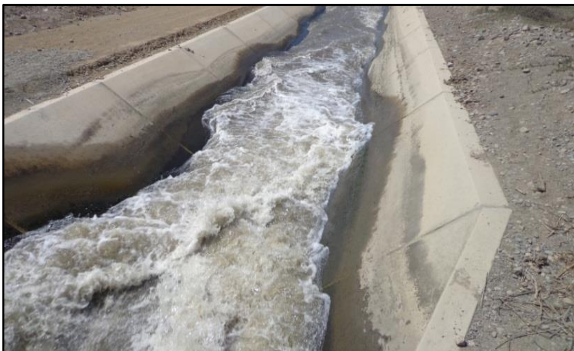
Figura 17: Sección inicial del canal donde se muestra el flujo turbulento no controlado.
