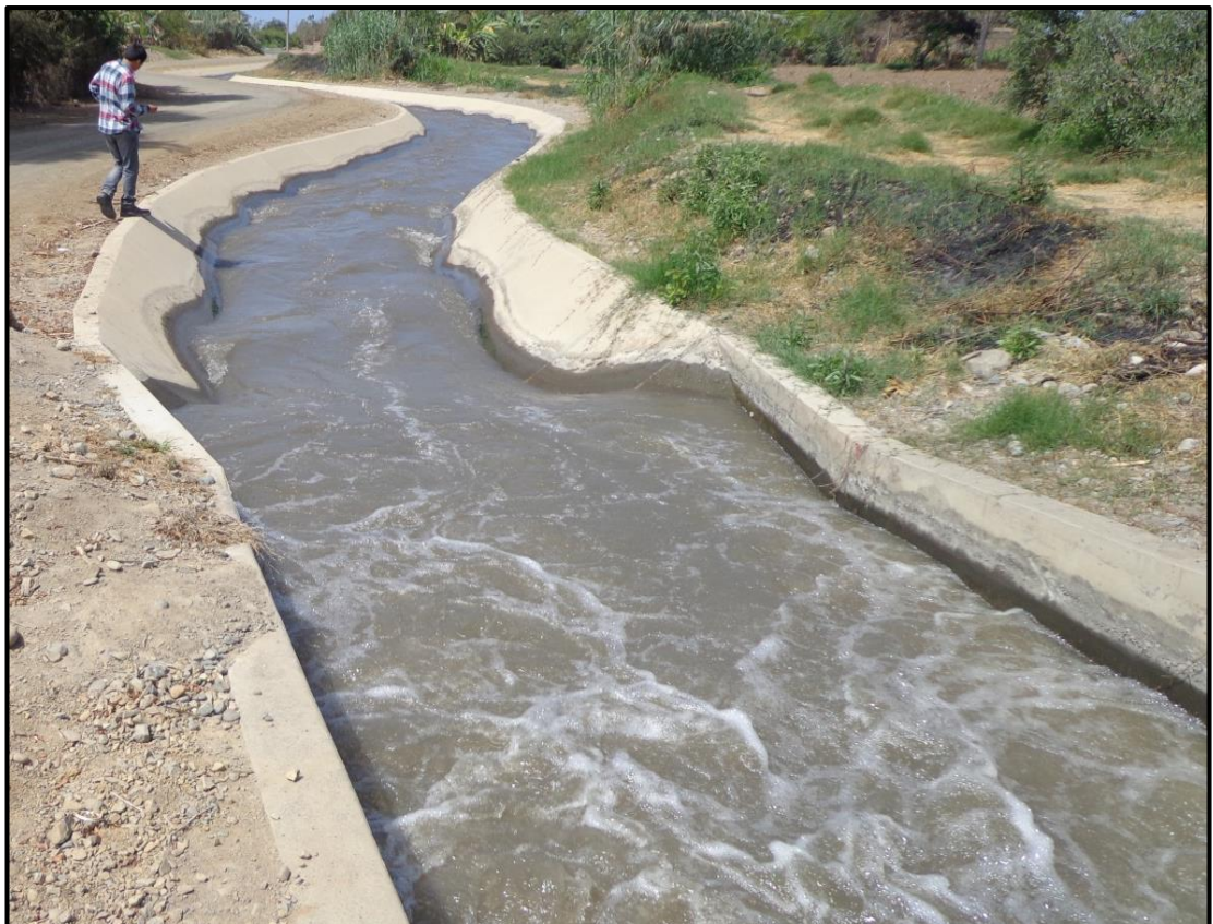
Figura 40-41: Flujo en Caídas Verticales, con turbulencia no controlado por el colchón disipador y transiciones de salida muy cortos para el cambio de sección.
