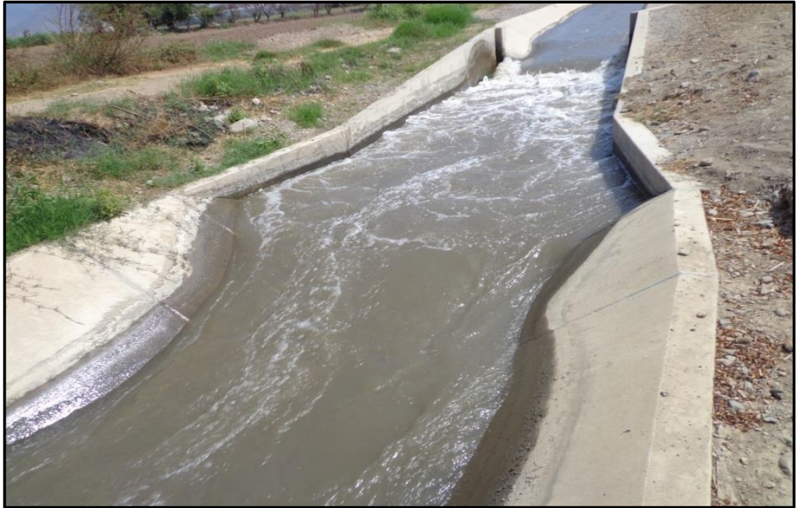
Figura 22: Vista de la arquitectura hidráulica de las caídas verticales
