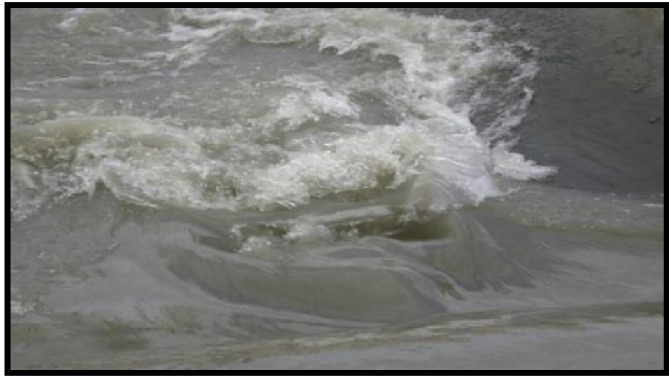
Figura 65-66: Incremento de la formación de oleajes y fenómenos hidráulicos aguas bajo de la estructura metálica.
