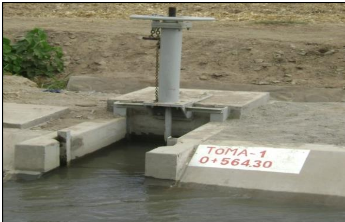
Figura 26: Toma 1 ubicado en la progresiva 0+564.30.
