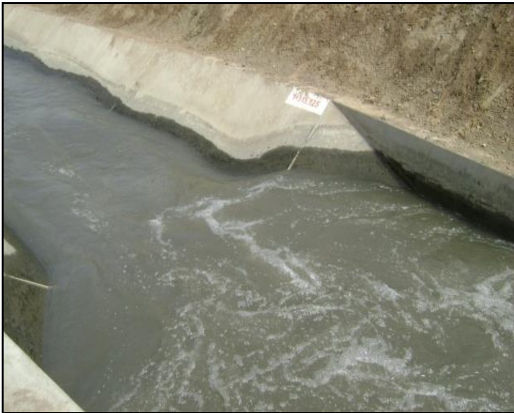
Figura 46-47: Transiciones de salida no contribuyen a la entrega uniforme del caudal.
