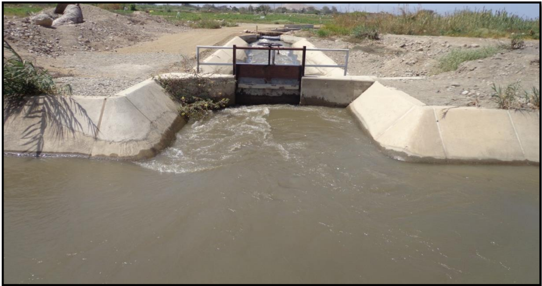
Figura 30: Derivación de un caudal de 1.8 \text{ m}^3/\text{s} aproximadamente, de la toma lateral del canal madre del proyecto Chavimochic.
