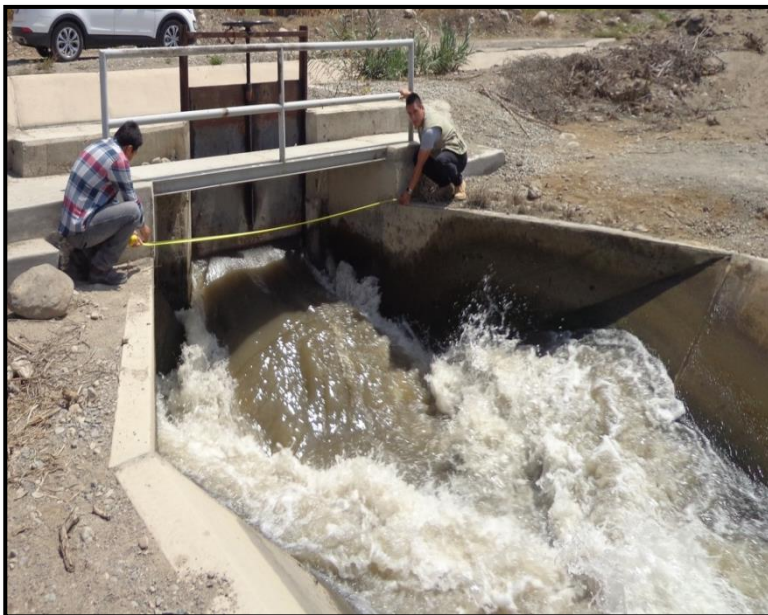
Figura 16: Vista de Transición de entrada del canal Chaquin.
