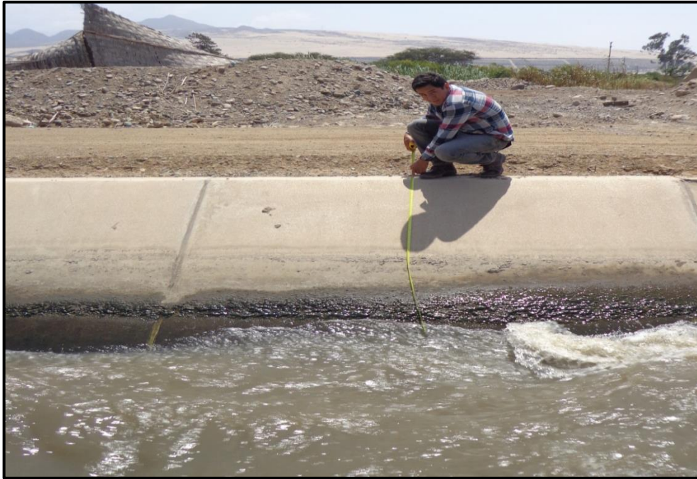
Figura 19: Verificando medidas referenciales en el primer tramo del canal Chaquin.
