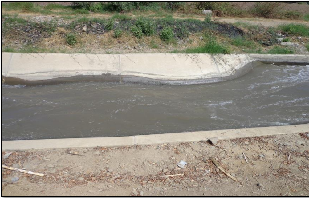
Figura 36: Tramo de canal con flujo turbulento desordenado y formación de oleajes.
