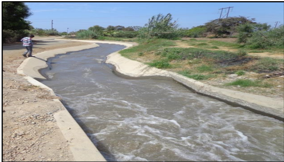
Figura 21: Vista del Canal sección típica en la Progresiva 00+027 km aproximadamente y el Oleaje que presenta.
