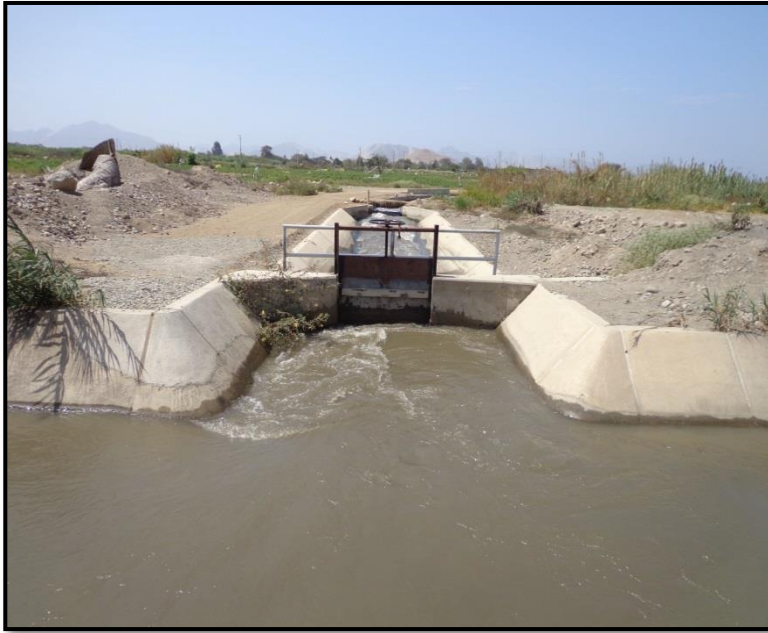
Figura 15: Estructura de inicio del Canal Chaquin, vista desde el Canal madre.
