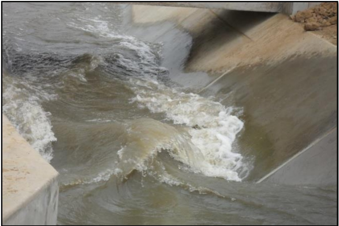
Figura 33: Formación de Resalto y Oleajes en la Transición de Salida de la Estructura de Inicio.
