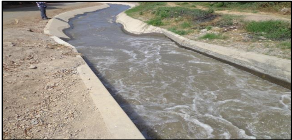
Figura 4: Canal Integrador “Chaquin”, Margen Derecha del Rio Virú.
