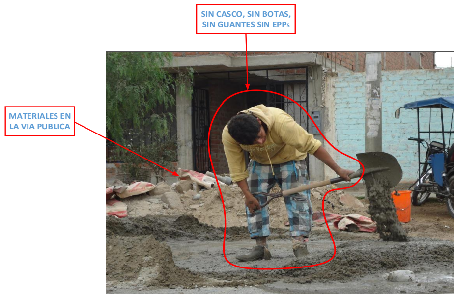
Figura 29 - Condiciones en la que se realiza el mezclado.
