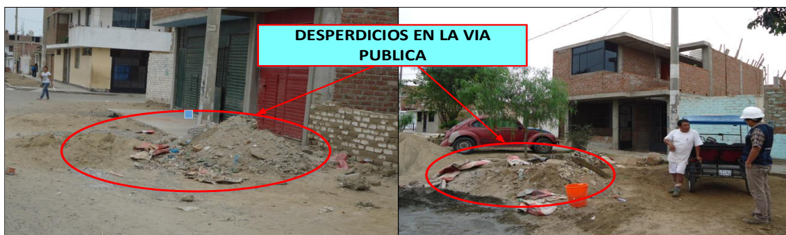
Figura 35 - Desperdicio en las construcciones.
