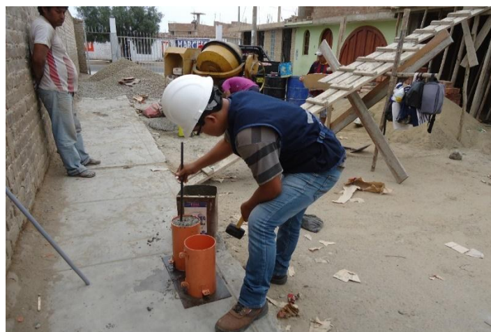
Figura 44 - Compactacion de la mezcla.
