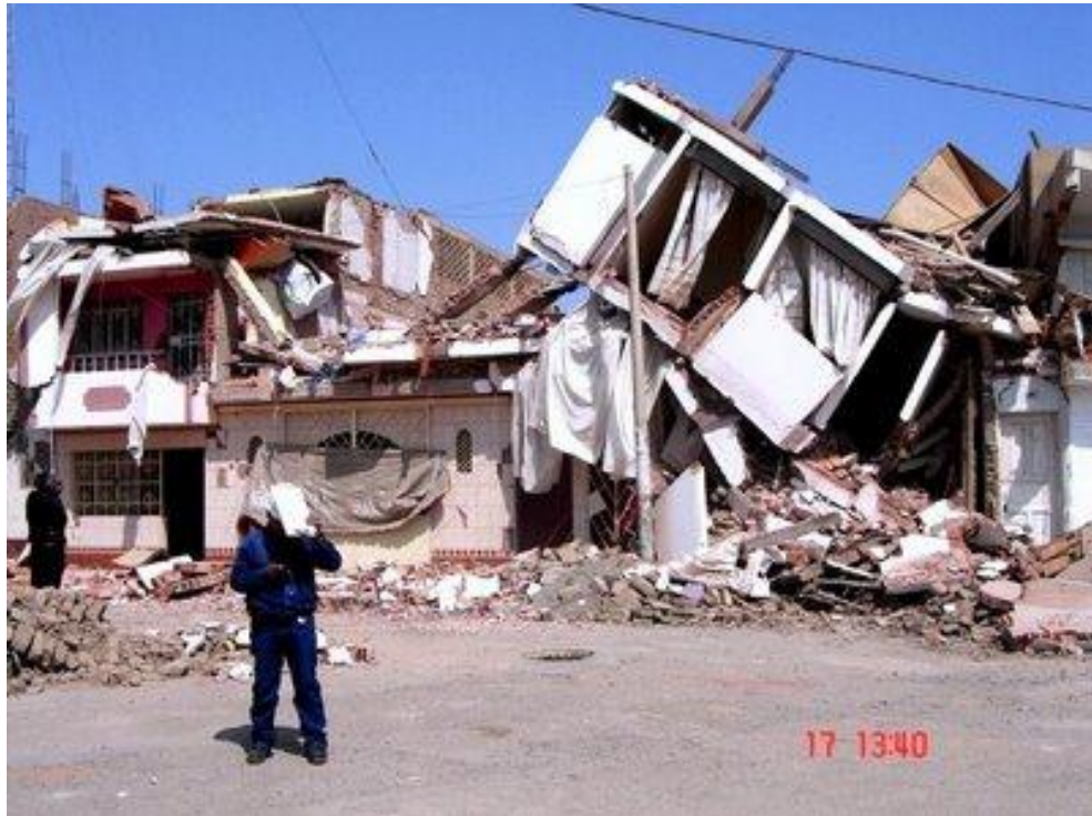
Figura 73- Falla de edificaciones por insuficiente número de columnas
