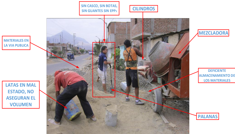
Figura 30 - Elementos para el mezclado.
