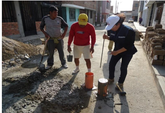
Figura 42 - Compactando la mezcla.
