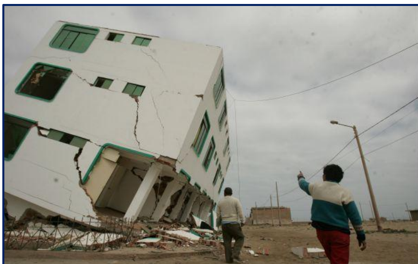
Figura 79-Terremoto en Pisco-Ica-Chincha en 2007
