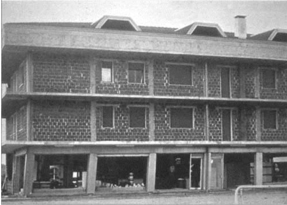
Figura 69- Edificio con falla por piso blando.
