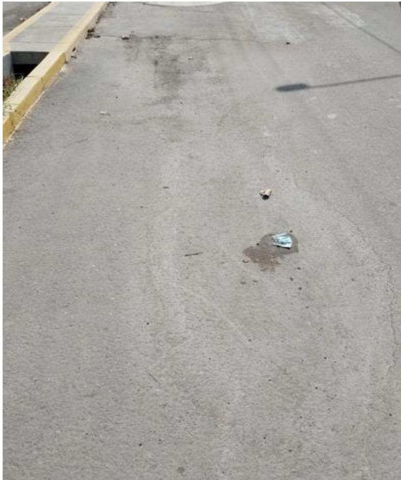
Figura 31. Ahuellamiento en la progresiva 0+800.
