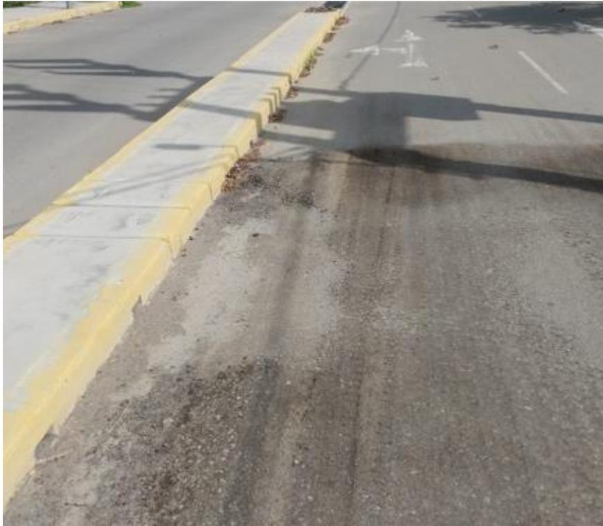
Figura 25. Degradación de la capa de asfalto por la acción de aceite derramado, progresiva 0+465
