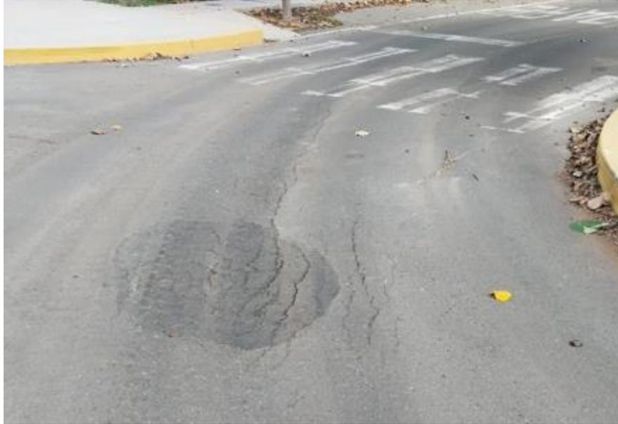
Figura 18. Ahuellamiento y piel de cocodrilo en la progresiva 0+155
