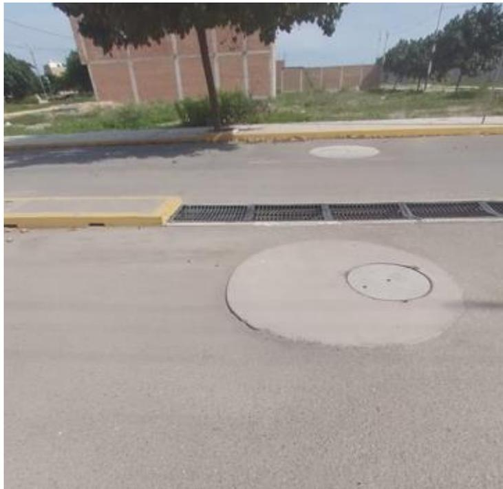
Figura 27. Hundimiento de la carpeta en la progresiva 0+495.
