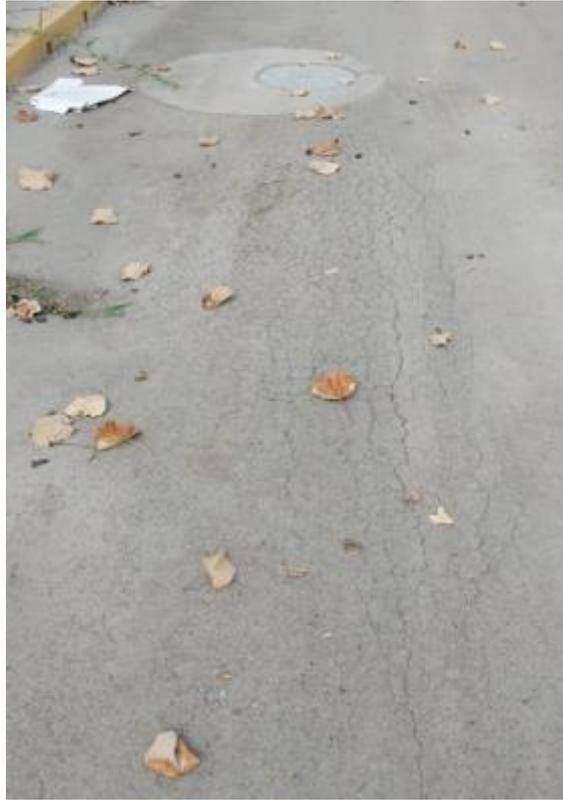
Figura 20. Piel de cocodrilo en la capa de asfalto en la progresiva 0+275.
