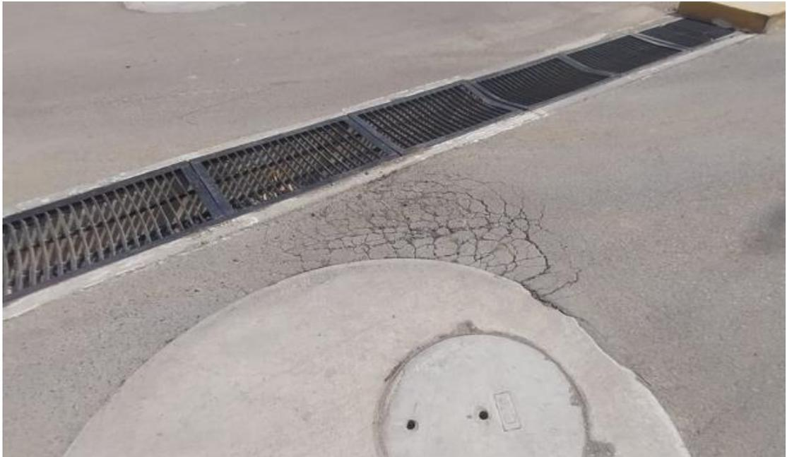
Figura 29. Hundimiento y piel de cocodrilo en la progresiva 0+630.
