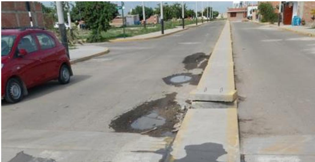
Figura 21. Hundimientos y bacheo en la progresiva 0+335.
