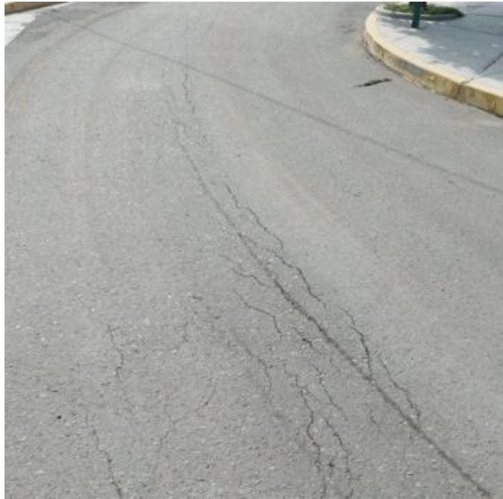
Figura 26. Fisuramiento longitudinal en zona de giro, progresiva 0+480
