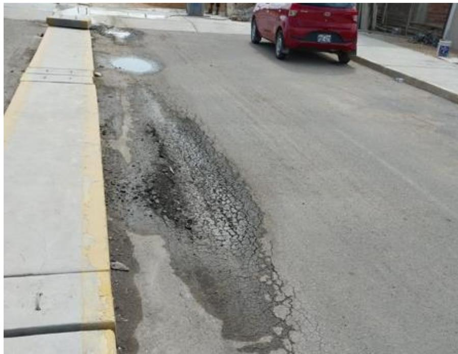
Figura 23. Hundimiento y piel de cocodrilo en la progresiva 0+420.
