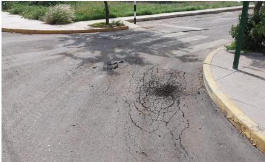
Figura 19. Ahuellamiento y piel de cocodrilo en la progresiva 0+172
