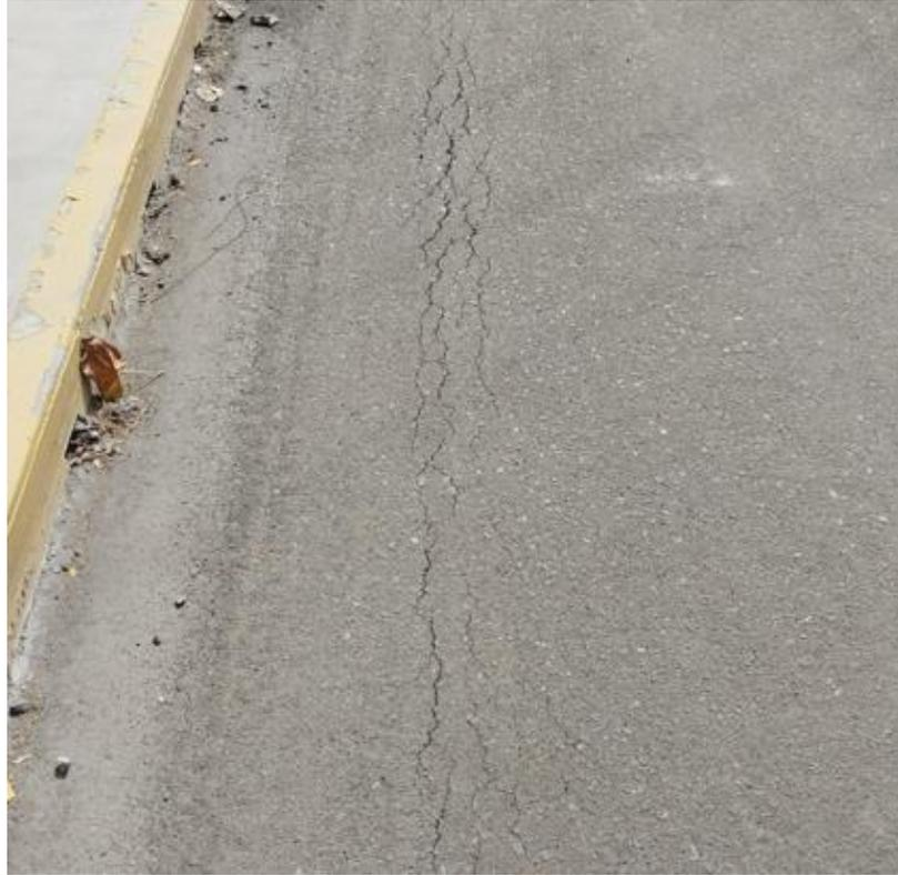
Figura 24. Fisuramiento longitudinal en la progresiva 0+445
