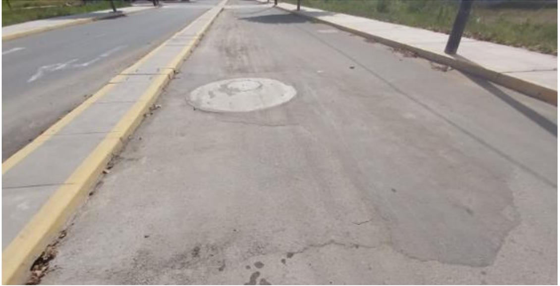
Figura 28. Parchado por hundimiento de la zona, progresiva 0+560.
