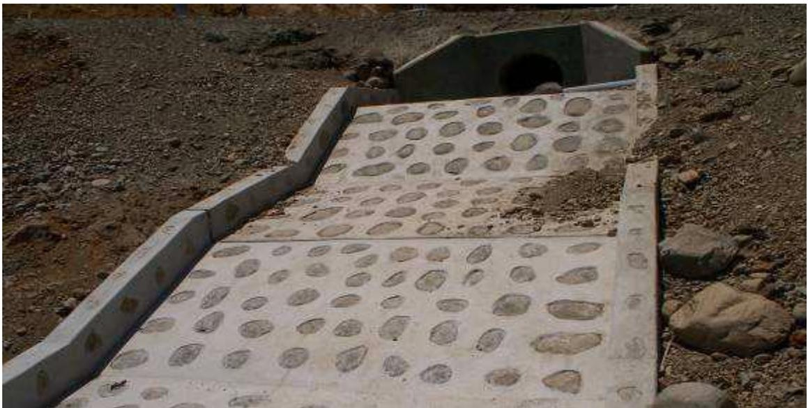
**OBRA:** Carretera Buenos Aires – Canchaque, Morropón, Piura (Vista General de Emboquillado a la Salida de Alcantarilla TMC).
