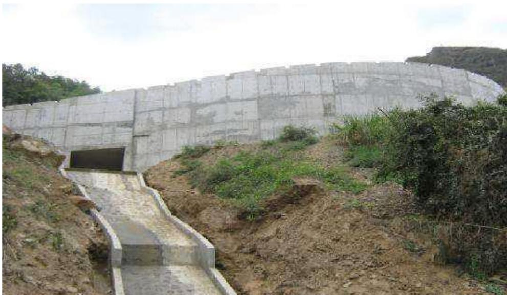
**OBRA:** Carretera Buenos Aires, Canchaque – Morropón - Piura (Vista General del Muro de Contención L= 100 ML)
