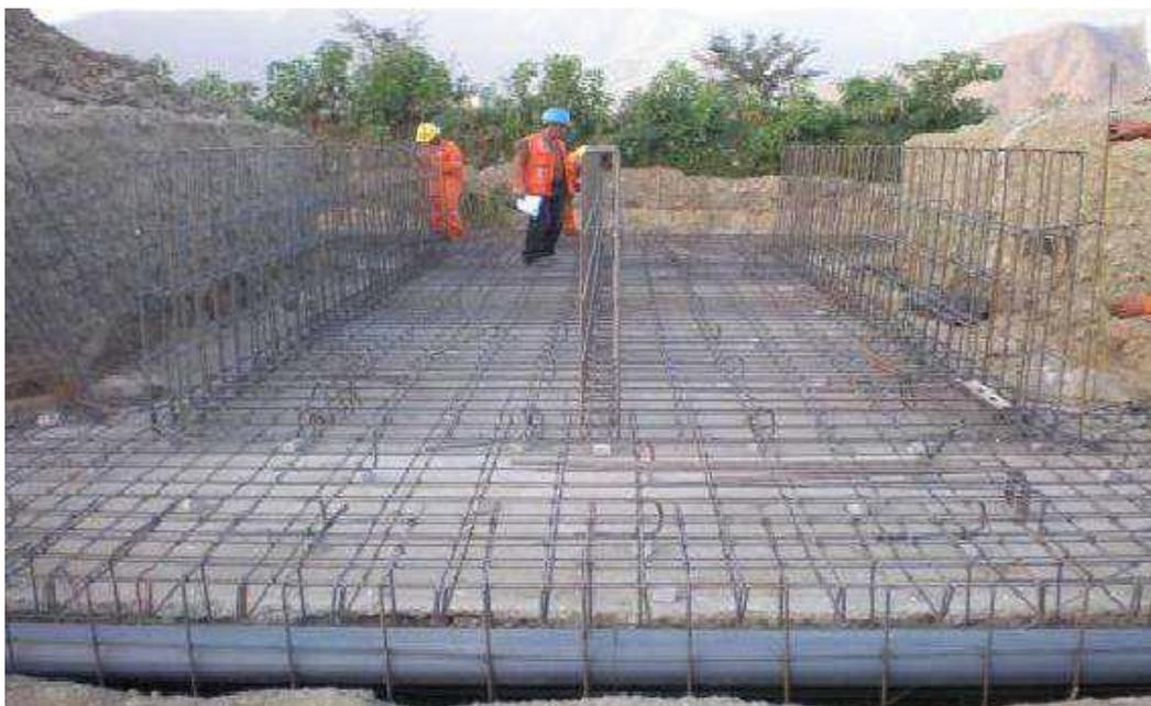
**OBRA:** Construcción de Alcantarillas – Carretera Buenos Aires – Canchaque, Morropón, Piura (Vista General de Fierro habilitado para Losa y Muros).
