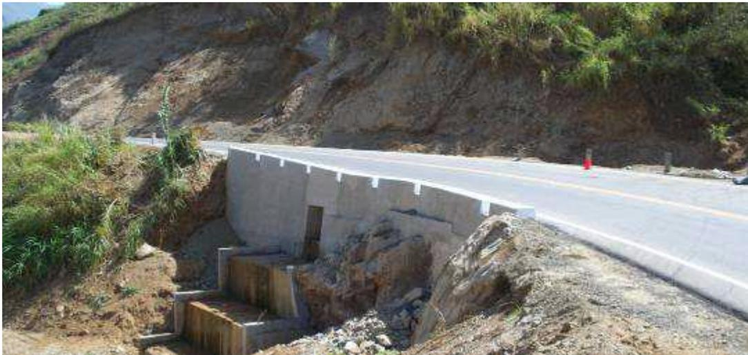
**OBRA:** Carretera Buenos Aires – Canchaque, Morropón, Piura (Vista lateral derecha de muro de contención terminado de L=50ML).
