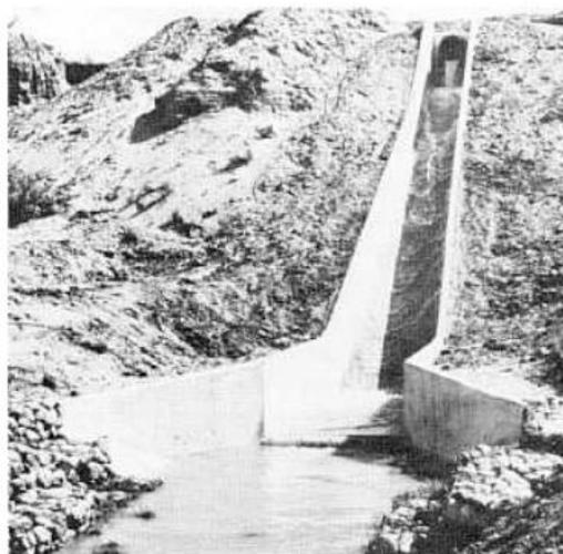
*Nota.* La figura representa una rápida con su respectiva poza amortiguadora para visualizar la gran pendiente que tiene, lo cual causa velocidades altas en el flujo. Información tomada de Design of Small Canal Structures (pp. 103) por Aisenbrey et al., 1978, United States Department of the Interior Bureau of Reclamation.
