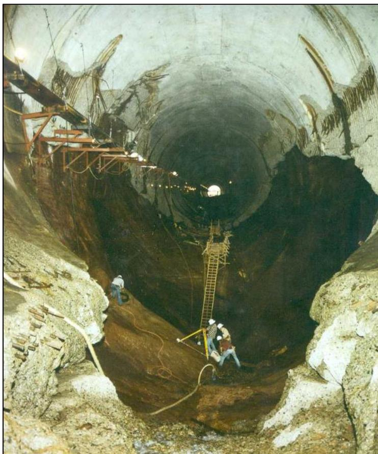
*Nota.* La figura representa el túnel de la presa del Cañón de Glen (Colorado – Estados Unidos), donde se visualiza a simple vista la enorme cavitación en el fondo de la pared del túnel de concreto armado. Tomado de *Cavitation in chutes and Spillways* (p. 06), por H. Falvey, 1990.
