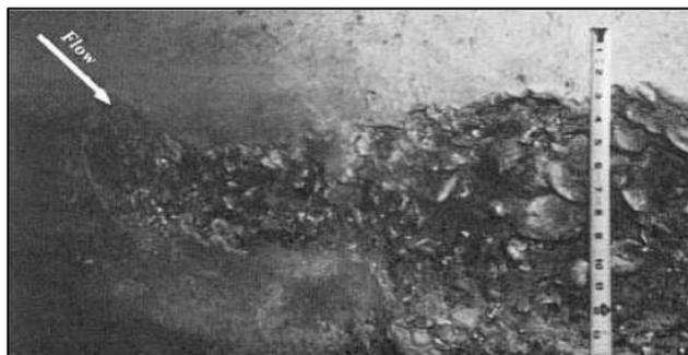
*Nota.* La figura representa el túnel de la presa de Hoover (Nevada – Estados Unidos), donde se visualiza a simple vista la enorme cavitación en el fondo de la pared del túnel de concreto armado. Tomado de *Cavitation in chutes and Spillways* (p. 43), por H. Falvey, 1990.
