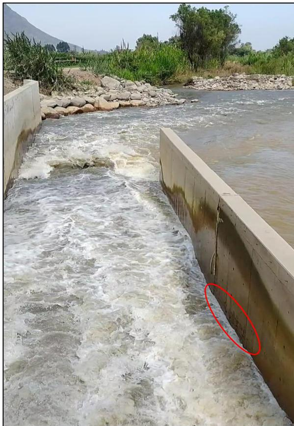
*Nota.* La figura representa la Bocatoma Huatape, Laredo, La Libertad, donde se visualiza una ligera cavitación en la pared derecha de concreto encerrado con un círculo rojo. Fotografía tomada en campo. Elaboración propia.
