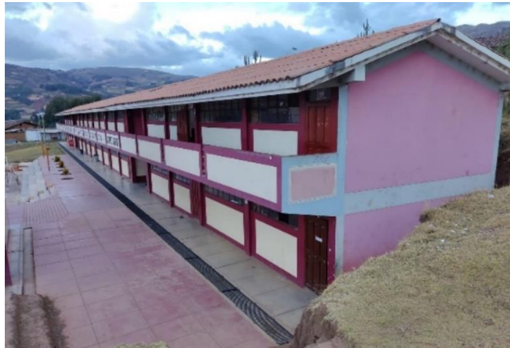
Figura 15 Vista Frontal del Pabellón C en estudio
