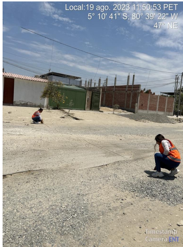
Foto 14. Toma de medidas de las fallas existentes en nuestra área de estudio
