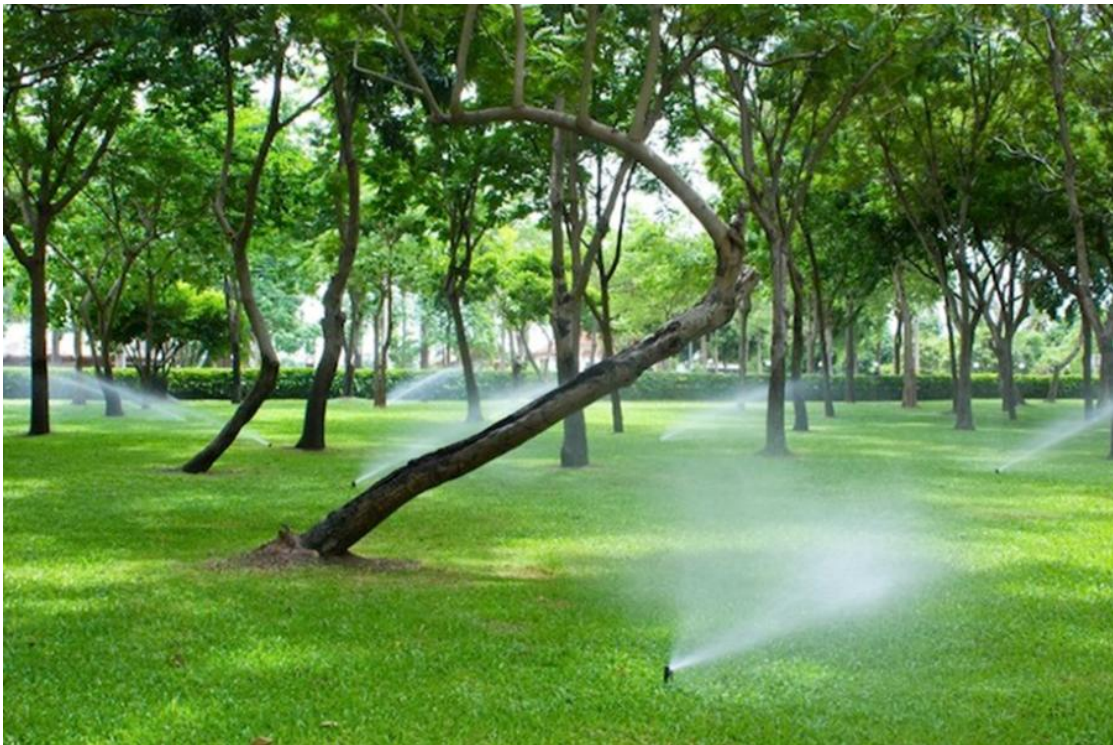
Fotografía N° 7: Vista de aspersores regando con agua residual tratada
