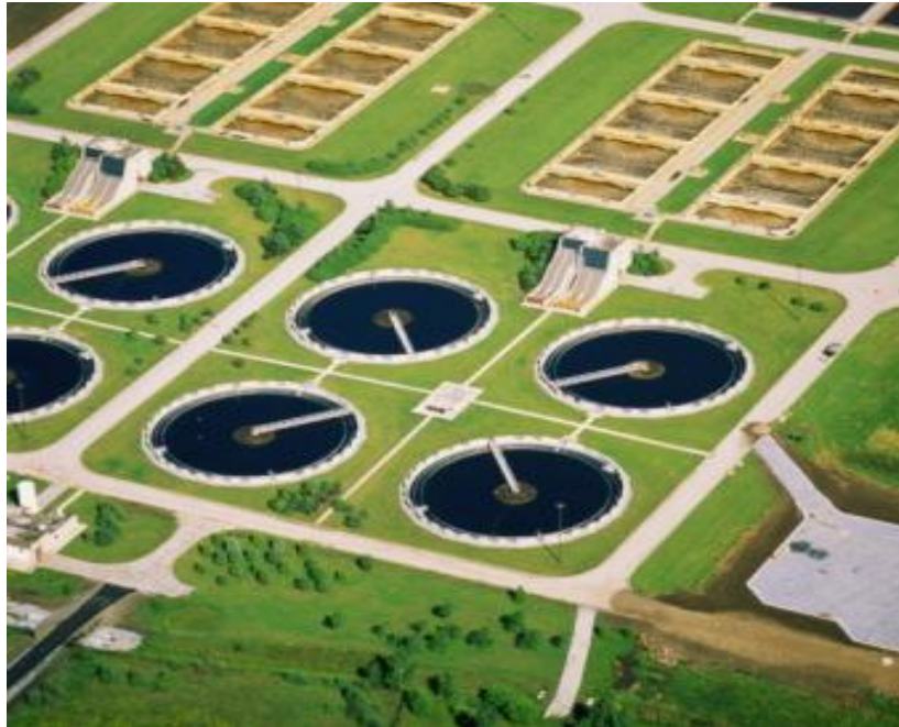
Fotografía N° 6 : Vista de una planta de tratamiento de Lodos Activados
