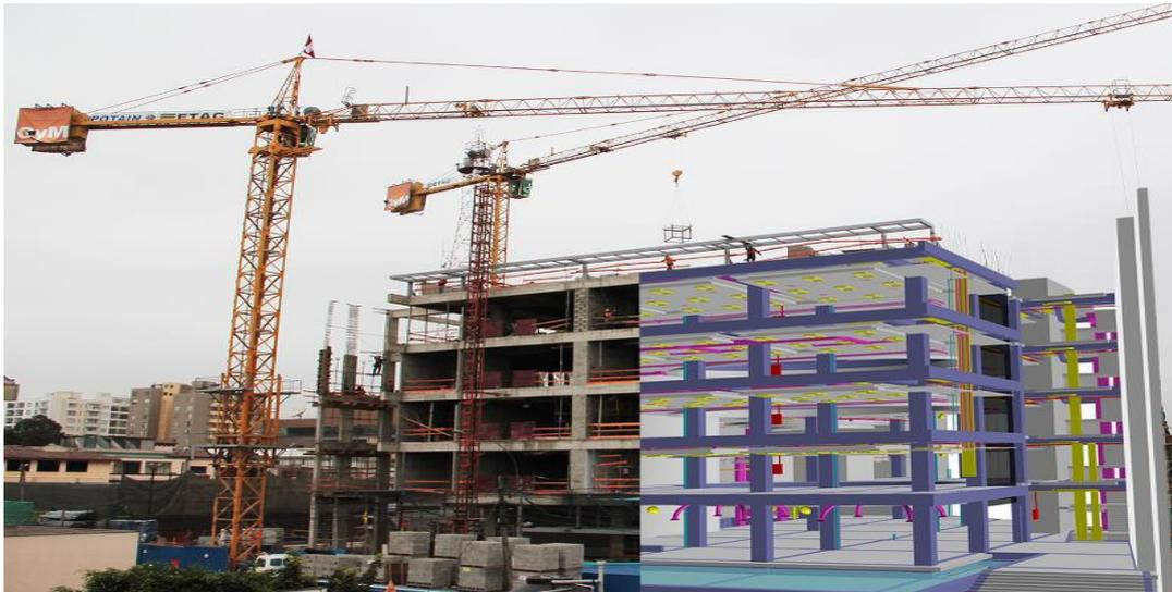
*Figura 1: Representación virtual tridimensional mediante el uso de BIM*
