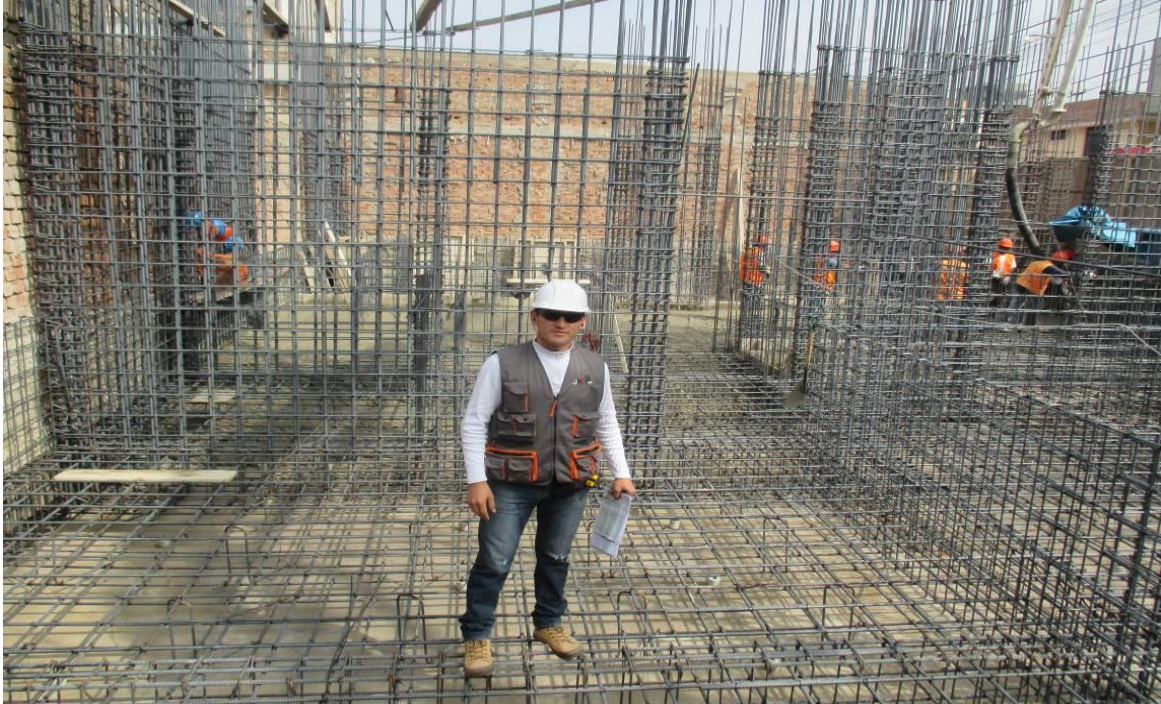
Yorman Quiroz Quispe Observando cada actividad el avance y con EPP
