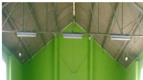
**Descripción:** Las cubiertas no se encuentran debidamente amarradas con tornillos o alambres y tampoco se encuentran debidamente apoyada a la estructura de cubierta de losa aligerada, por ello le corresponde una calificación "D".
