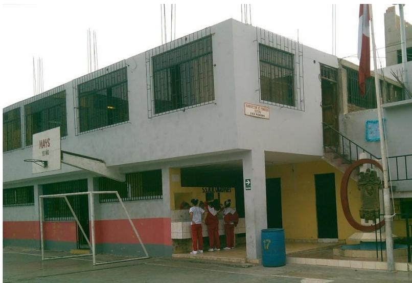
**Descripción:** La estructura no presenta buena conexión entre el diafragma y los muros, presenta losa aligerada y su deformabilidad es despreciable, por ello le corresponde una calificación “C”.
