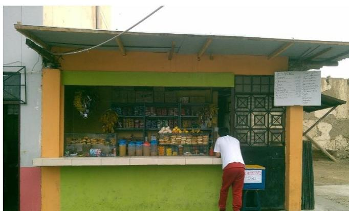
**Descripción:** Las cubiertas no se encuentran debidamente amarradas con tornillos o alambres y tampoco se encuentran debidamente apoyada a la estructura de cubierta de losa aligerada, por ello le corresponde una calificación “D”.
