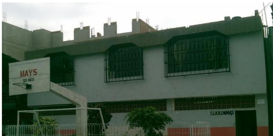
**Descripción:** La estructura no presenta buena conexión entre el diafragma y los muros, presenta losa aligerada y su deformabilidad es despreciable, por ello le corresponde una calificación “C”.
