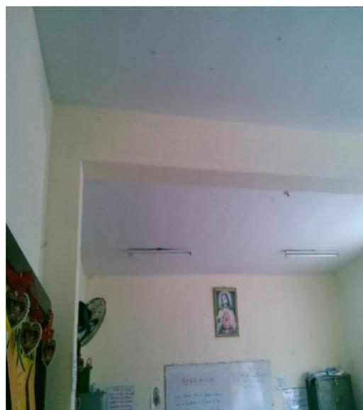
**Descripción:** Las estructuras no presentan buena conexión entre el diafragma y los muros, presenta losa aligerada y su deformabilidad es despreciable, por ello le corresponde una calificación "C".
