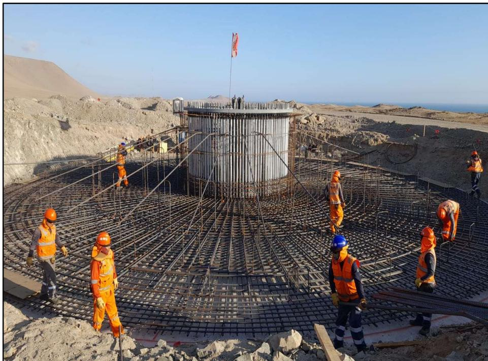
*Ilustración 4. Colocación de acero pre-dimensionado.*
