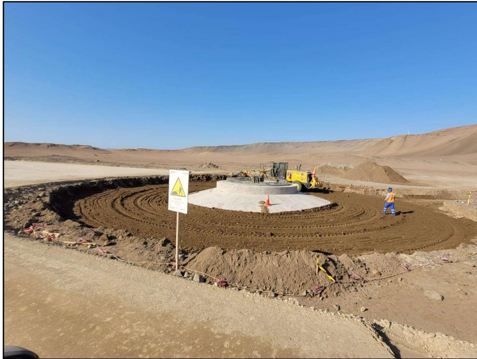
*Ilustración 7. Relleno fundación de aerogenerador.*
