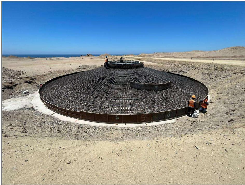
*Ilustración 5. Encofrado de fundación de aerogenerador.*
