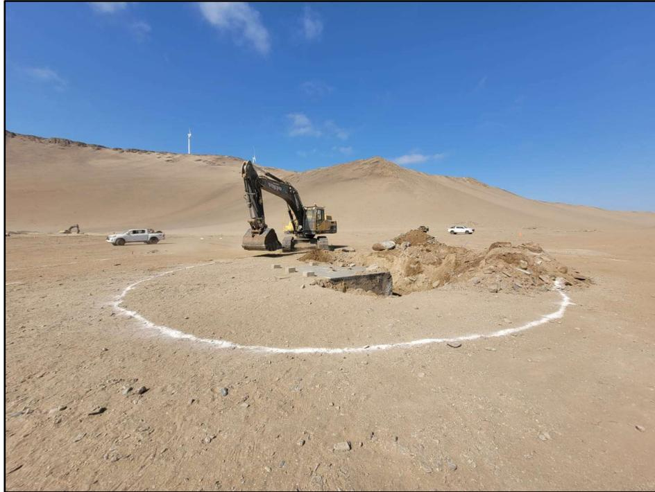
*Ilustración 1. Excavación para fundación de aerogenerador.*
