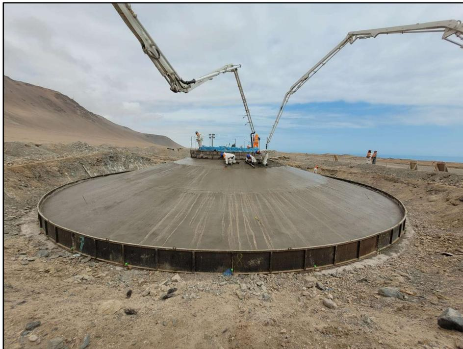
*Ilustración 6. Vaciado masivo de losa y pedestal de fundación de aerogenerador con concreto premezclado.*
