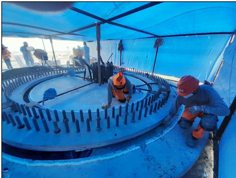
*Ilustración 8. Colocación de Grout en aerogeneradores.*
