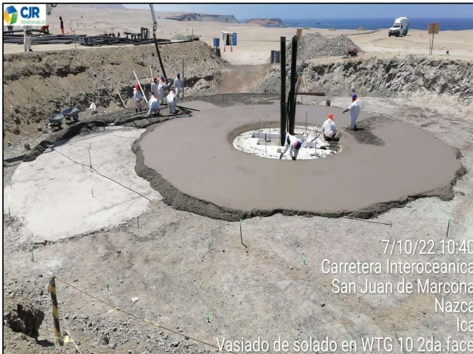
*Ilustración 2. Vaciado de segundo nivel de solado, después de colocar el poliestireno e:20 cm.*
