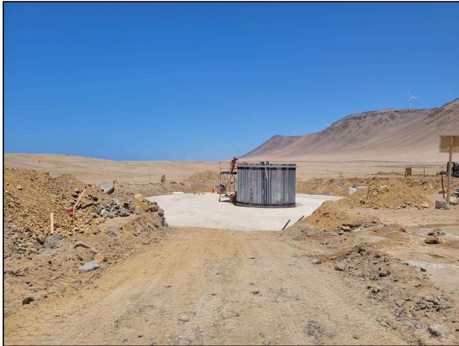
*Ilustración 3. Montaje de Jaula de Pernos.*
