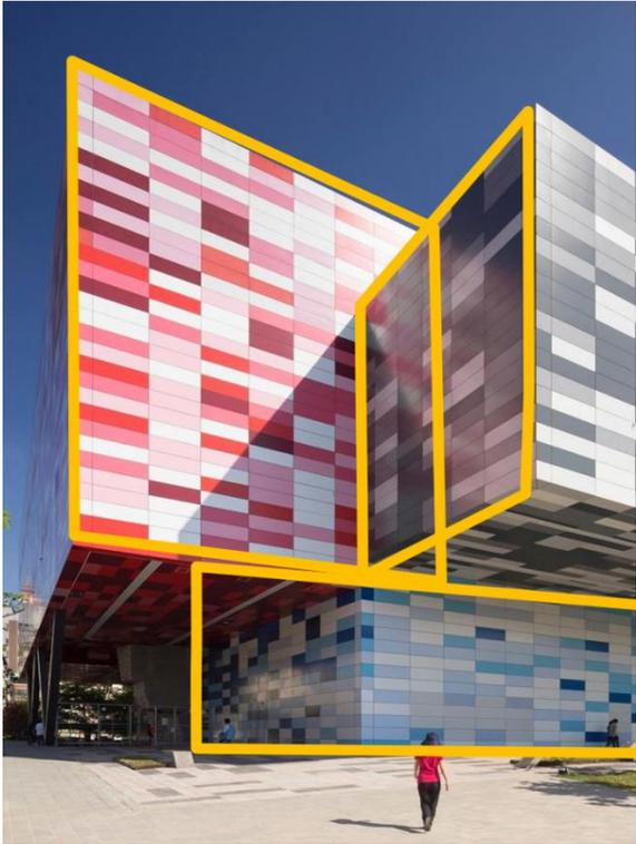
El exterior del edificio está revestido con un sistema compuesto ventana/muro, que incorpora aluminio perforado en su frente y aislamiento/vidrio en la parte posterior, permite que la luz del sol se filtre suavemente en el espacio interior. (Archdaily , 2015)
