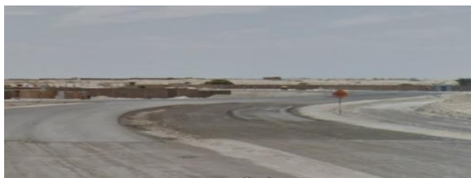
Vía Colectora SN Fuente: Elaboración propia.
