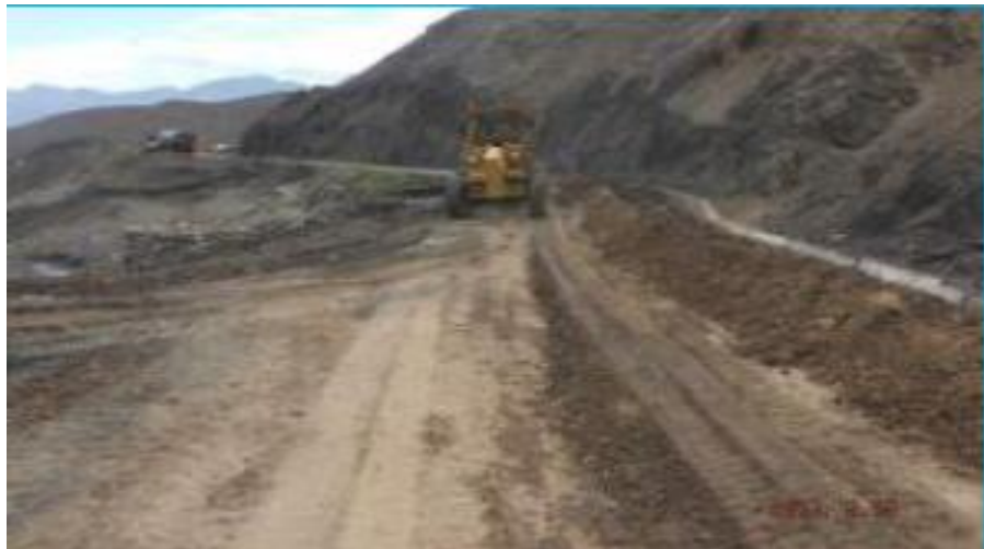
Foto 2: Aplicación el material con aditivo conaid.
