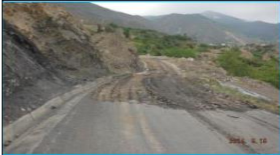
Foto 1: Proceso de conformación de zonas donde se aplicara el material con aditivo.
