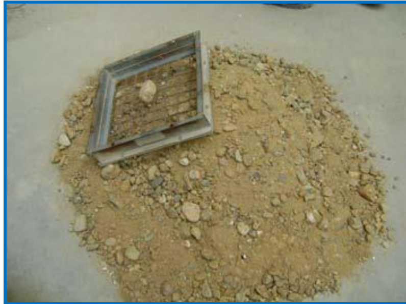
Foto 4: Tamizado del afirmado y de la arcilla
