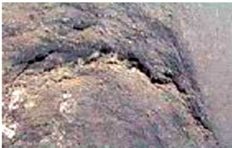
Figura 19: Grietas Parabólicas
