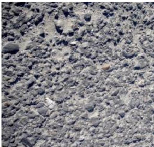
Figura 14: Pulimento de Agregados
