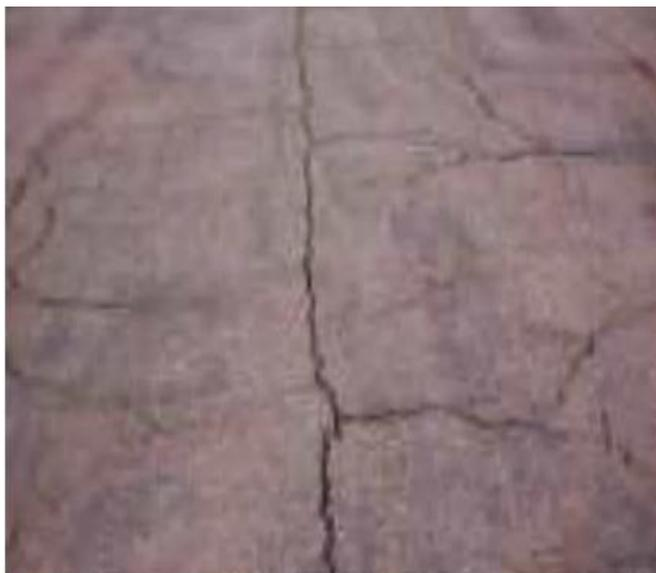
Figura 5 : Agrietamiento en Bloque
