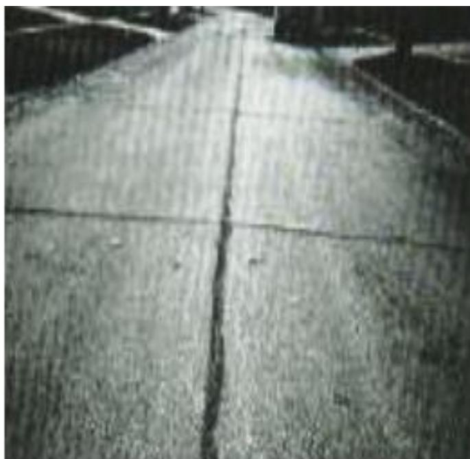
Figura 10: Grieta de Reflexión de Junta
