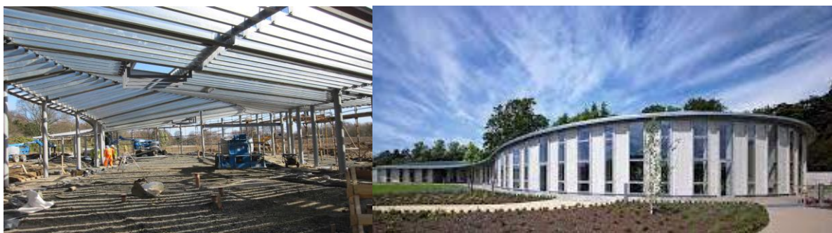
Figura 149: Sistema aporticado de estructura metálica.
