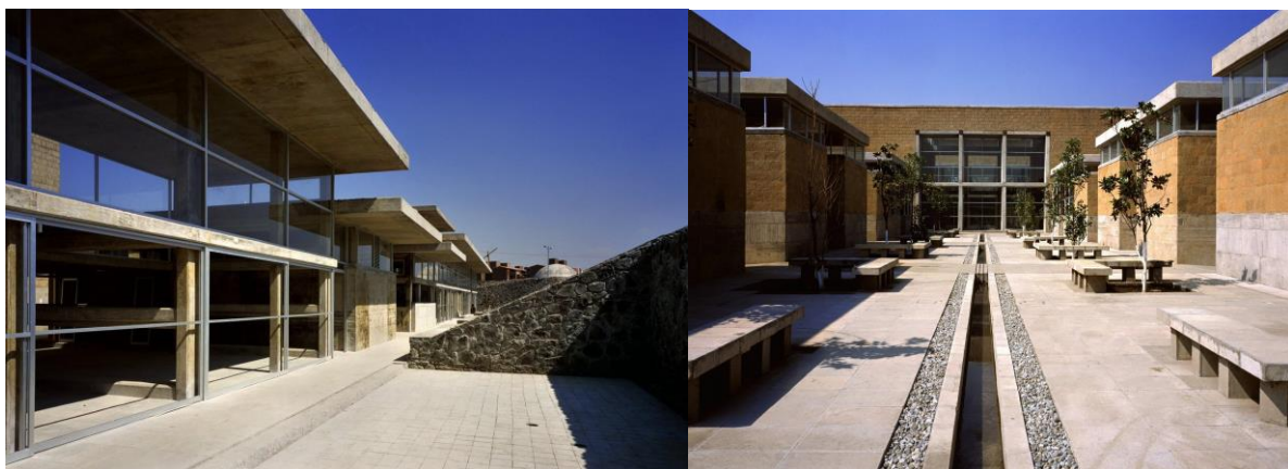
Figura 142: Materialidad del bloque administrativo - Materialidad de los bloques de aulas.
