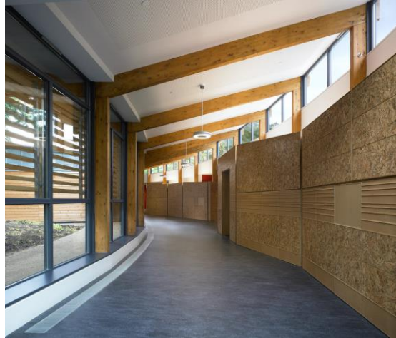
Figura 133: Aplicación de paneles OSB como guías táctiles.
