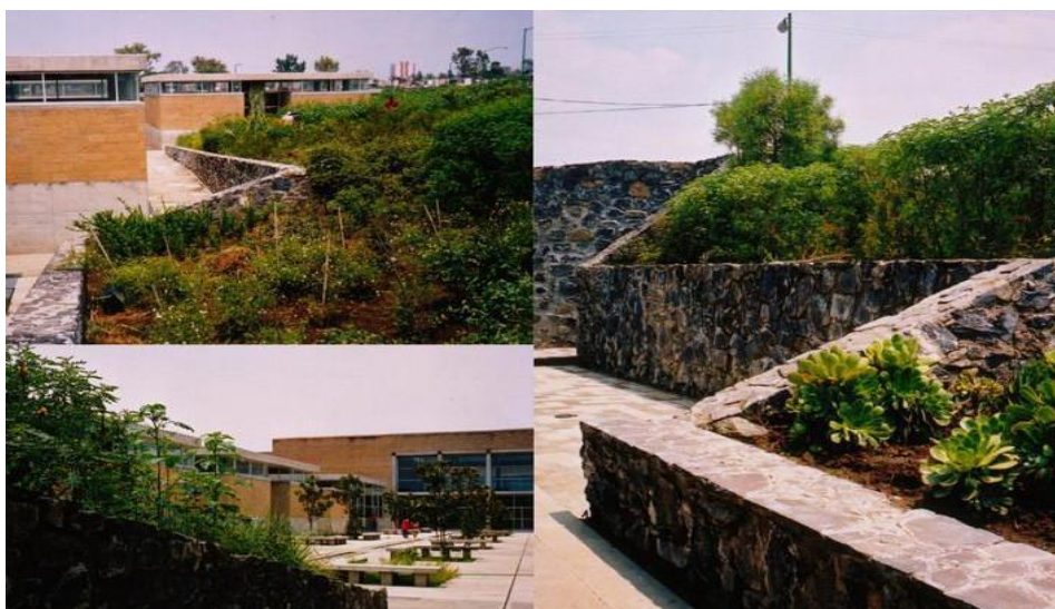
Figura 138: Cerco perimétrico, talud y colchón verde del Centro de Invidentes y débiles visuales.
