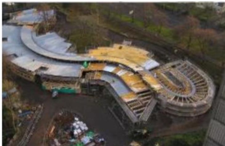
Figura 134: Proceso constructivo - Estructura Hazelwood School.
