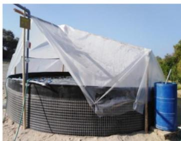
**Figura 4** *Instalación de film térmico*
