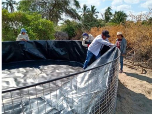
**Figura 3** Instalación de geotanques
