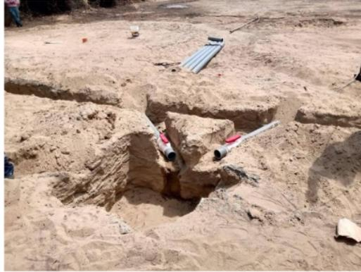
**Figura 2** *Construcción de suministro de agua y drenaje*
