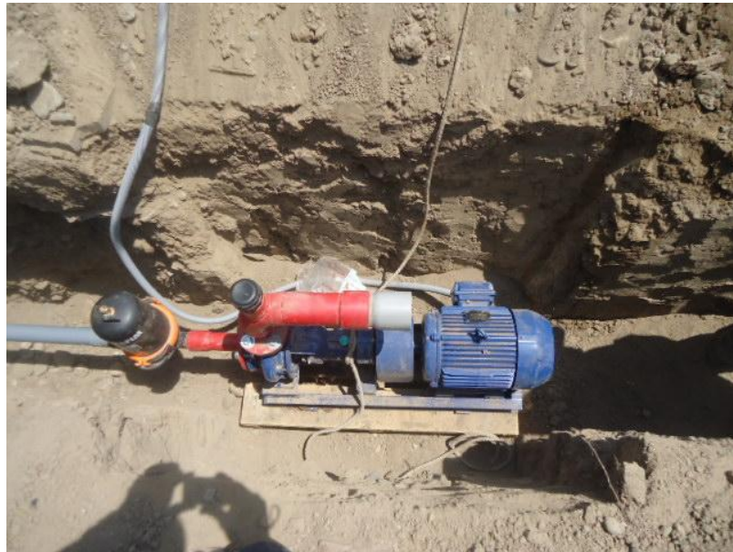
Anexo 18. Instalación de bomba en sistema de riego por goteo.
