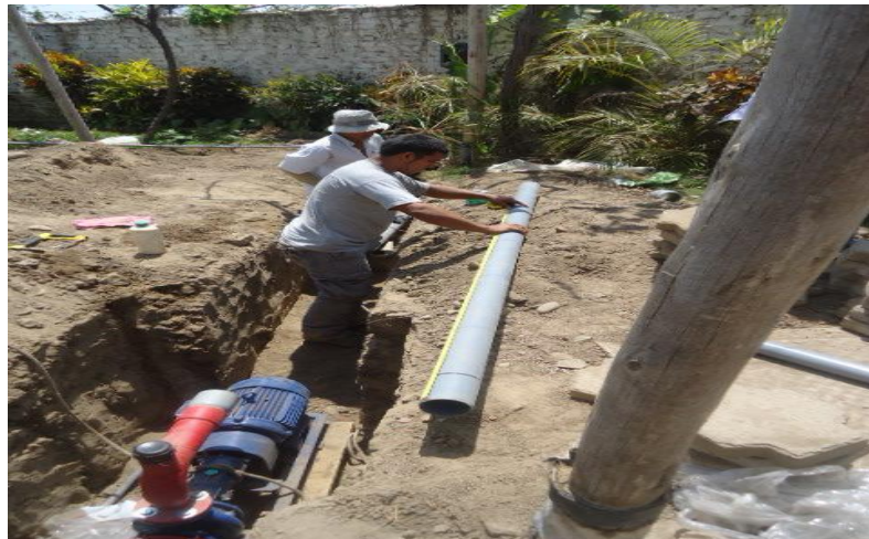
Anexo 19. Instalación de la tubería principal.
