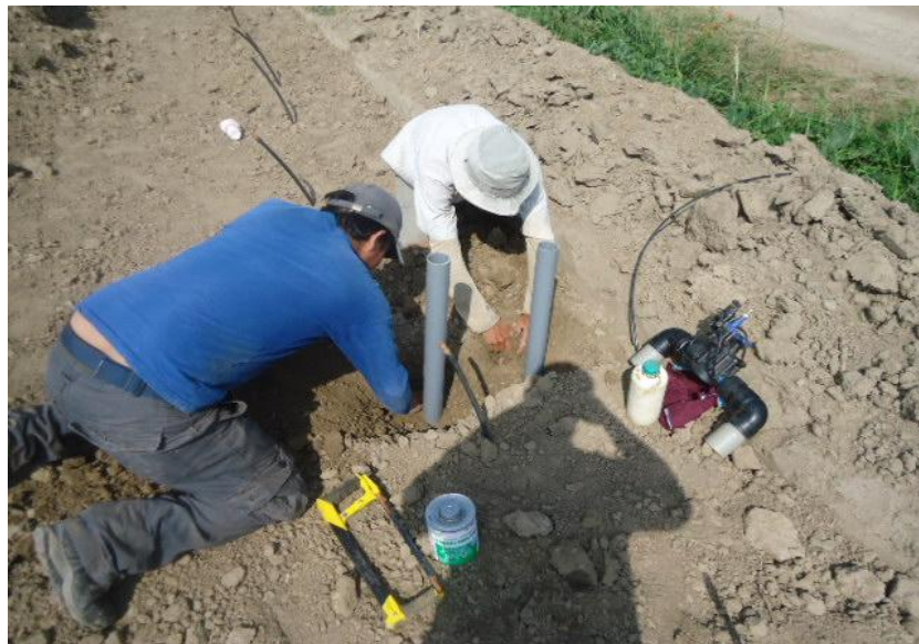
Anexo 21. Instalación de válvula. Fuente: Original del autor.
