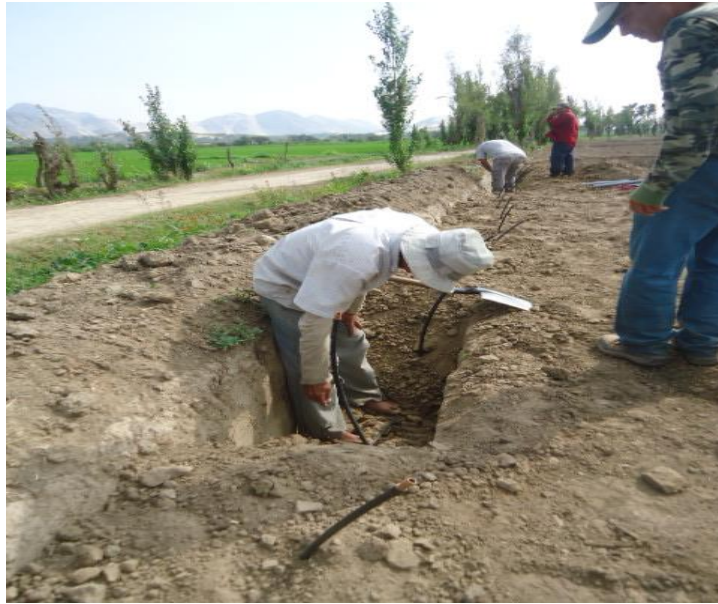
Anexo 22. Instalación de mangueras laterales.
