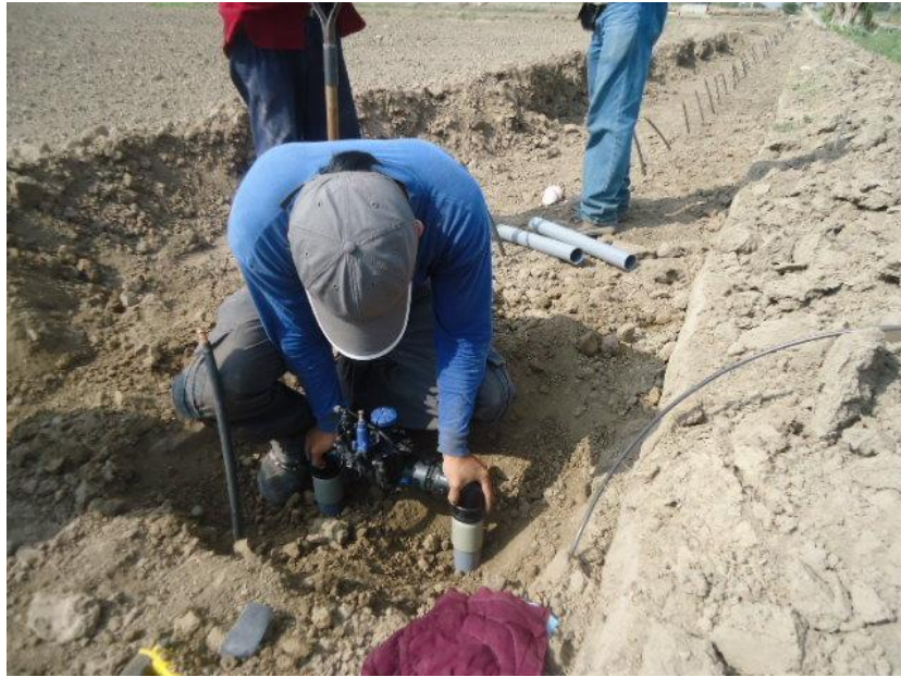
Anexo 20. Instalación de la válvula para el sistema de riego Fuente: Original del autor.
