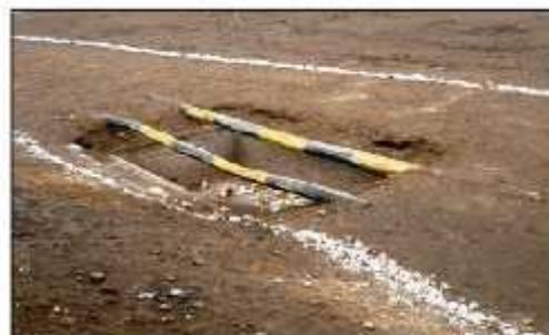
**5. Puente:** Una fosa de 3.5 m de largo por 5 metros de ancho y 1 m de profundidad. A lo largo del foso van colocadas 4 vigas separadas 1 metro una de otra.
