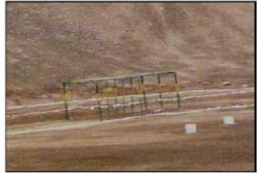
**11.- Plataforma:** comprende una fosa de arena de 5m de largo por 2.5 metros de ancho y 50 cm de profundidad, también tiene una escalinata de 2.50 metros de altura por 4.00 m de ancho, contiene 6 peldaños y una plataforma en la parte superior de 40 cm de ancho.
