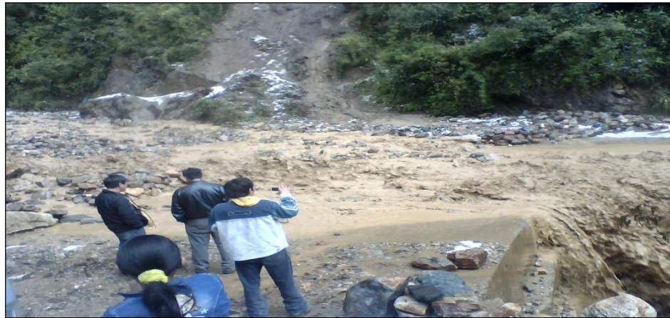
Se muestra el banco de piedra grande y mediana, hormigón en el cauce del río Canchan a la altura del cruce por donde pasa la carretera hacia chillia y en la parte baja del recorrido del río.
