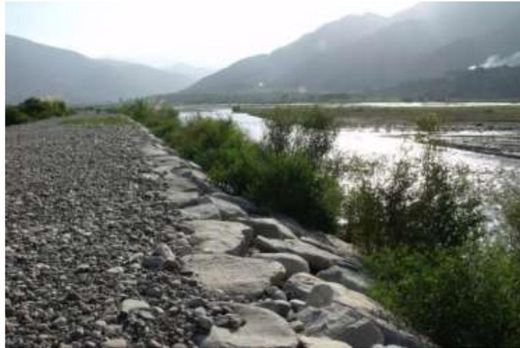
**Figura 3-5. Dique existente de material homogéneo (Construido por el PERPEC en el 2006), protegido por enrocados extraídos de la cantera propuesta para el presente estudio (Quebrada El Limo) con buenos resultados**
