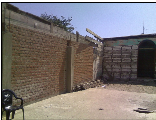
Figura IV-08. Muros Existentes a Demoler
