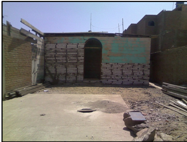
Figura IV-07. Interior de Construcción Existente
