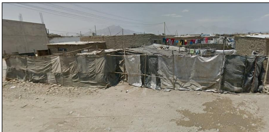
Figura N° 31: Ocupación del terreno y habilitación viviendas provisionales. Sector VI-B – C.P. El Milagro (Fuente: Los Autores)
