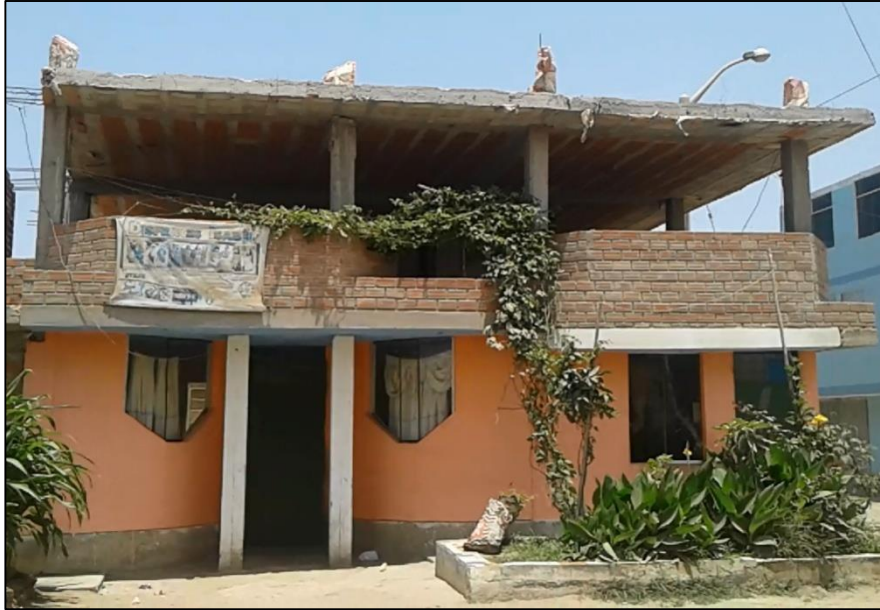
Figura N° 6: Vivienda Conformada por Ladrillos de Arcilla - Sector IV – C.P. El Milagro (Fuente: Los Autores)
