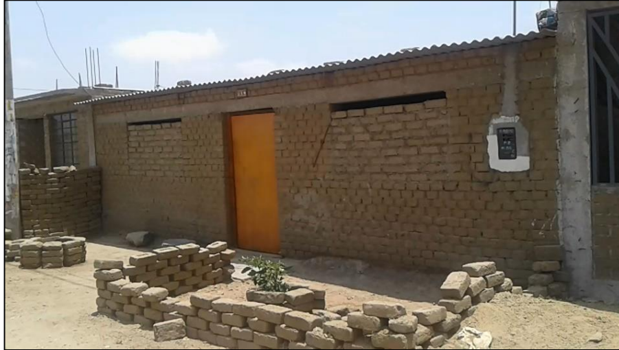
Figura N° 7: Vivienda Conformada por Ladrillos de Adobe - Sector V – C.P. El Milagro (Fuente: Los Autores)
