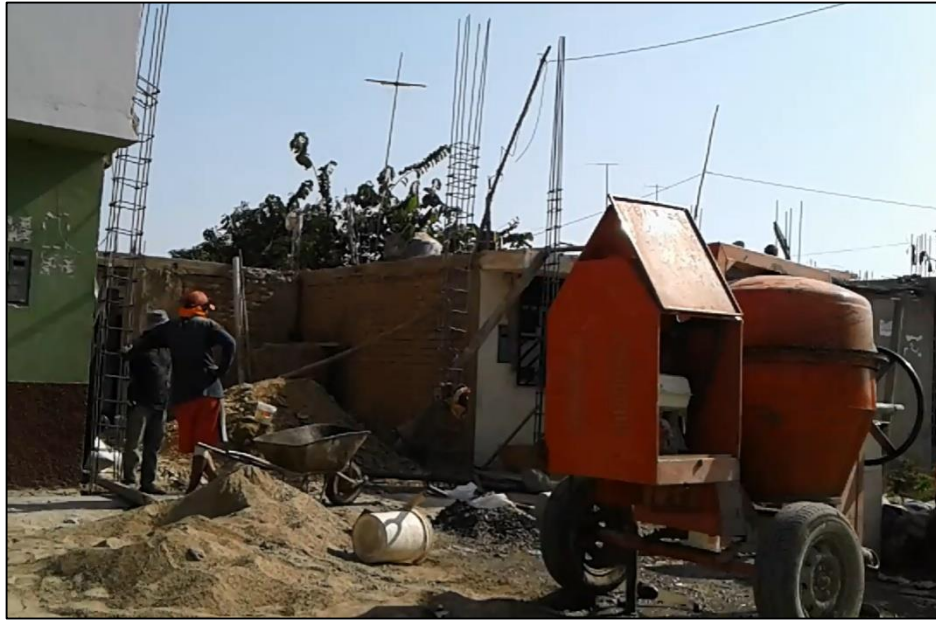
Figura N° 33: Zapata y columna armada
