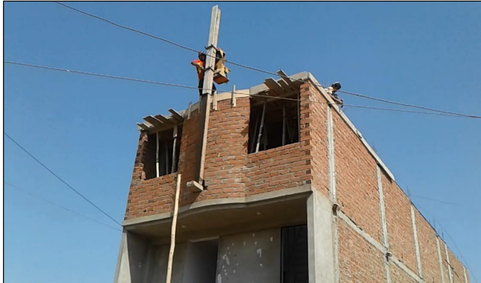
Figura N° 35: Preparado de la losa aligerada para su vaciado Sector V - El Milagro (Fuente: Los Autores)
