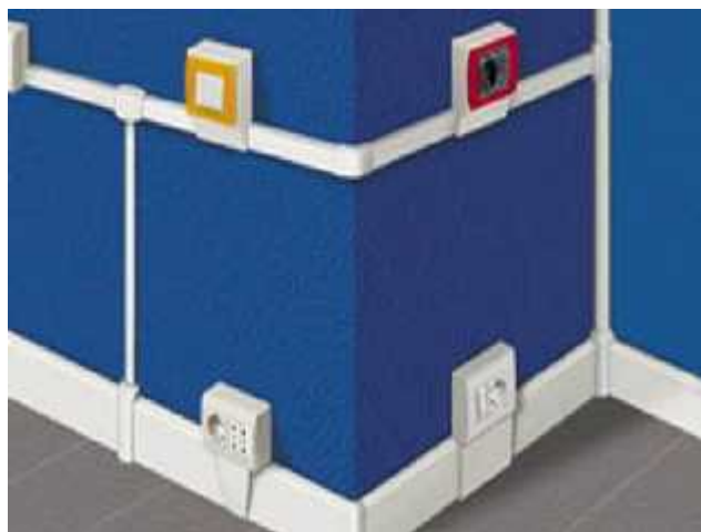
Figura 66: Uso de canaletas para instalaciones eléctricas
