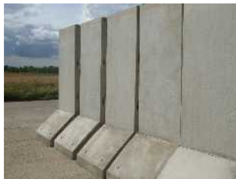
Figura 8: Muro de contención para excavaciones profunda.
