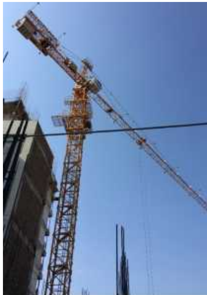
Figura 67: Transporte de los elementos prefabricados con grúa torre – COAM SAC – Trujillo 2017
