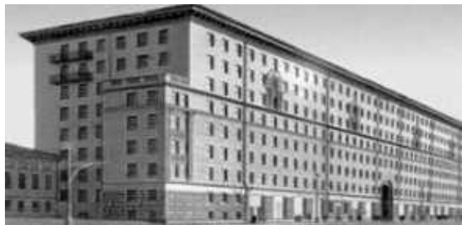
Figura 5: Edificio Bolshaya Kaluzhskaya Moscú. Construcción industrializada basada en diseños cerrados.
