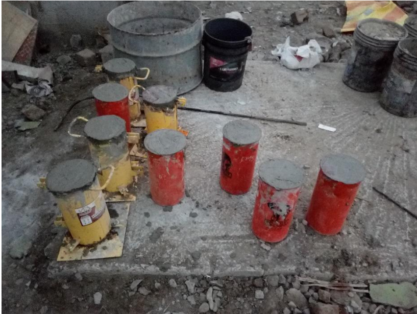
Llenado de Probetas de 30 (altura) y 15 de (diámetro) según las (NTP)
