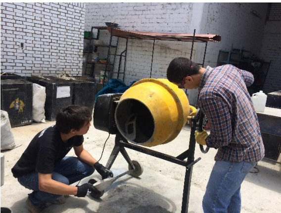
Foto N°15: Preparación de mezcla de concreto en mezcladora eléctrica (a).
