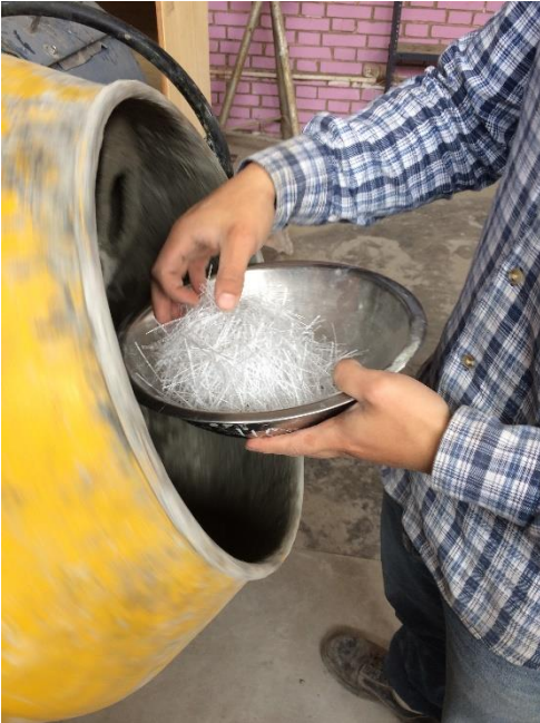
Foto N°17: Introducción de macro-fibras a la mezcla de concreto.
