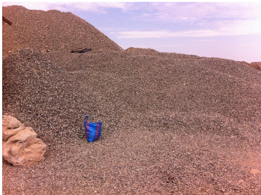
Foto N°8: Apilado del agregado angular de \frac{3}{4} ".
