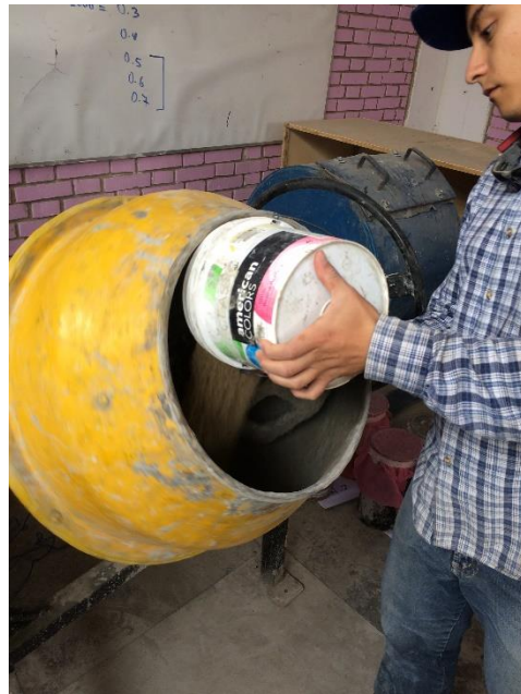
Foto N°16: Preparación de mezcla de concreto en mezcladora eléctrica (b).
