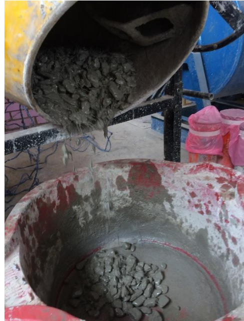
Foto N°18: Vertido de concreto con fibras.
