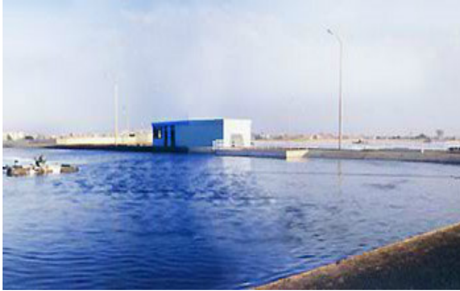
Fotografía N°02 : Vista de Laguna de Oxidación El Cortijo, con los aireadores en la superficie. Fuente: SEDALIB
