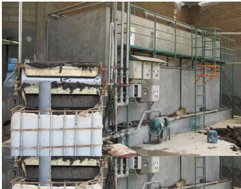
Fotografía N° 06 : Filtro de Pelo y piscina homogenizadora de baño de pelambre de la cutiembre Chimu Murgia Hnos SAC. (Av. América Oeste 110. Urb.Los Cedros. Trujillo).
