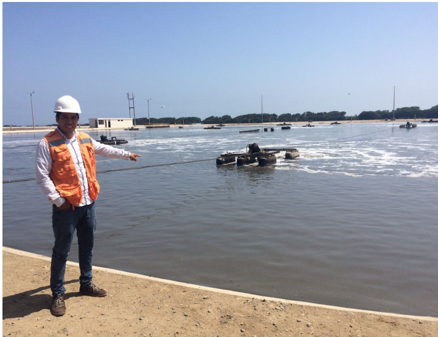
Fotografía N° 03 : Vista de Tesista en laguna de oxidación Covicorti, con aireadores
