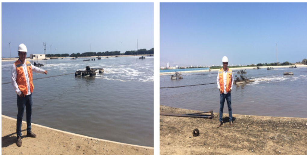
Fotografía N° 04 : Vistas de Tesista en lagunas de oxidación de Covicorti y El Cortijo ; con aireadores
