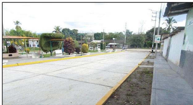
**Imagen N° 1-3** Vista de un pavimento rígido.
