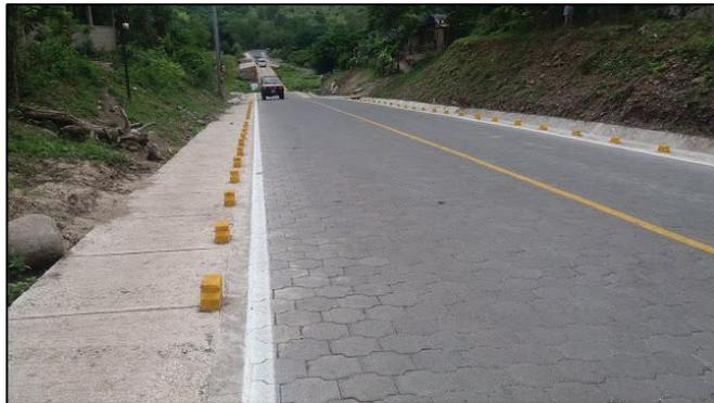
**Imagen N° 1-4** Vista de un pavimento articulado
