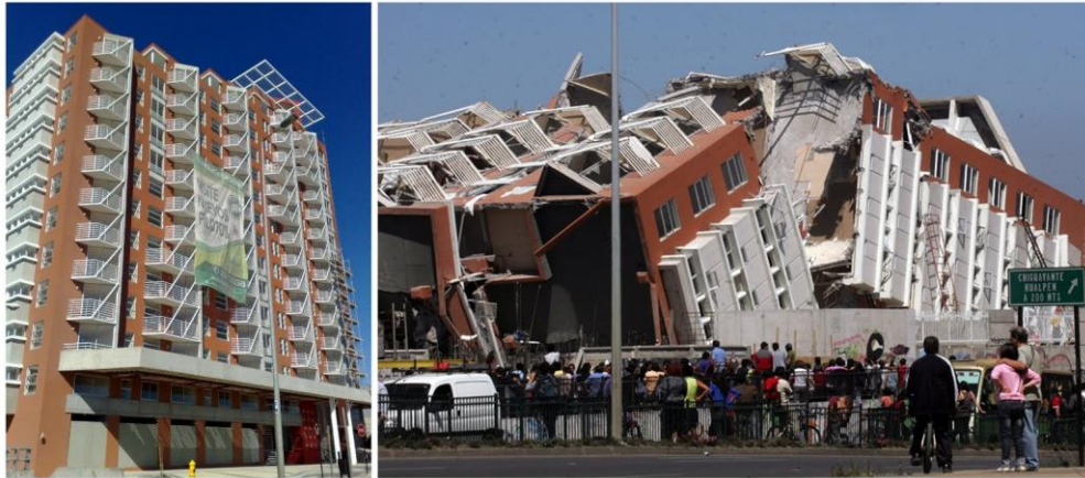
Fig. 1.2. Edificio “Alto Río” – Sismo Chile, Octubre 2010
