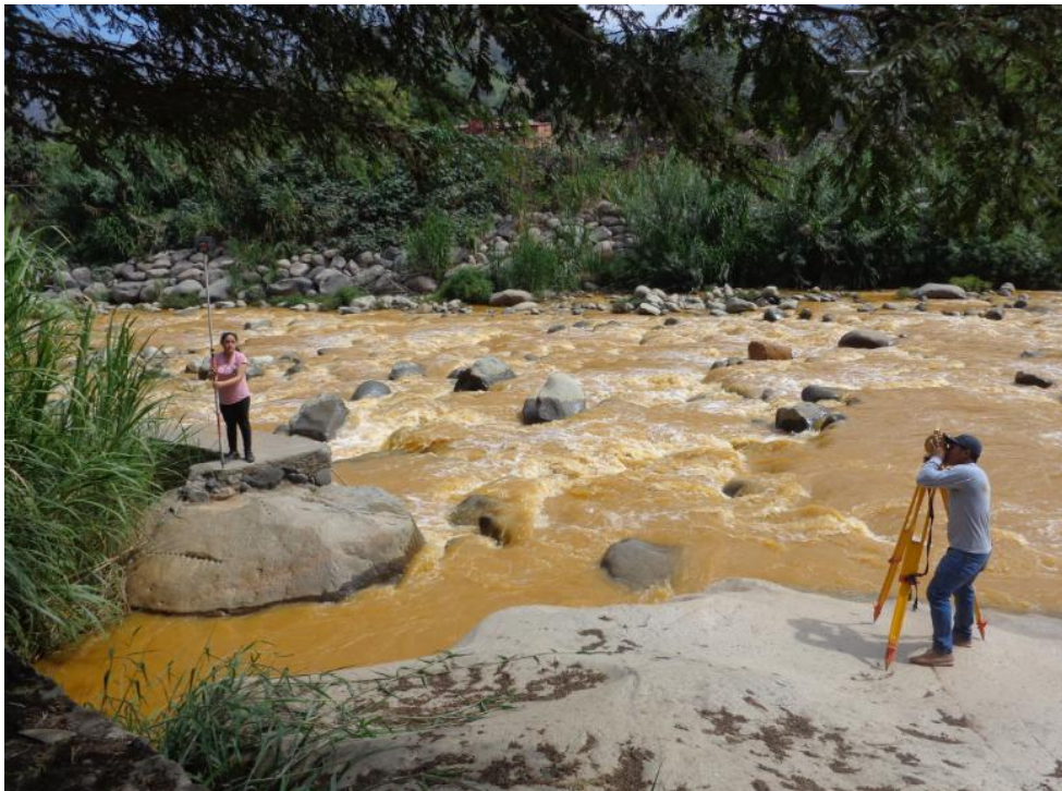
TOPOGRAFIA EN LA VENTANA DE CAPTACION
