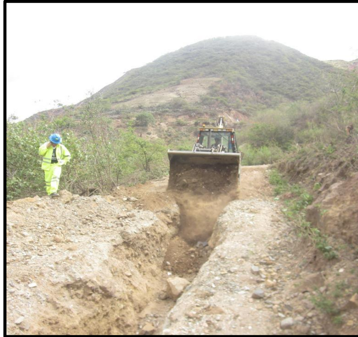
Fotografía 03 – Excavacion de zanja con retroexcavadora.
