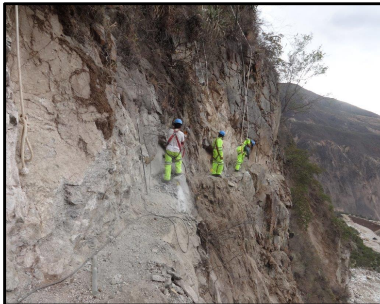
Fotografia 02 – Excavacion de zanja para tuberia en zona inaccesible.
