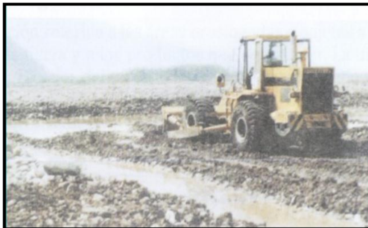
Figura 22. Limpieza del cauce
