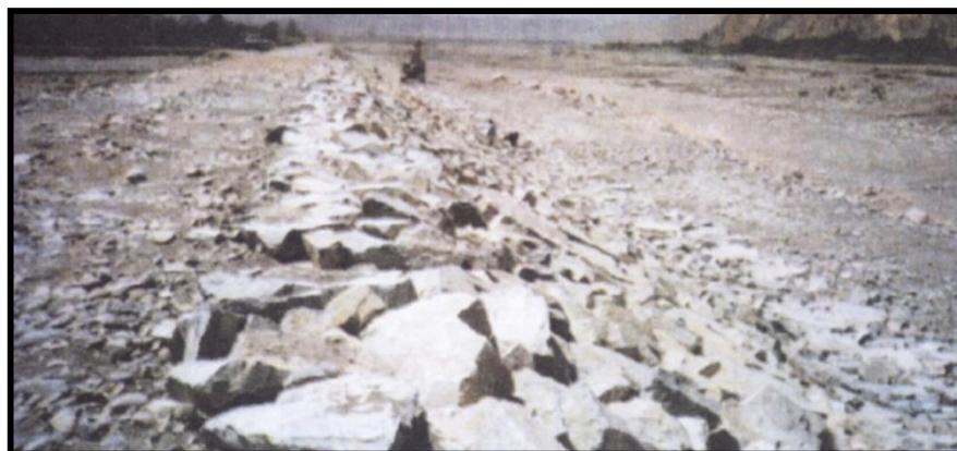
Figura 16. Enrocado con roca colocada
