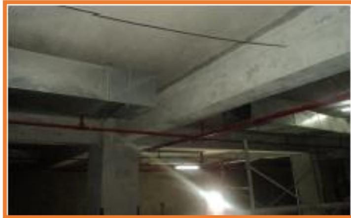
La Figura I-11 muestra una interferencia entre las instalaciones de Agua Contra Incendio (ACI) y los ductos de extracción de monóxido (HVAC); en este caso las tuberías de ACI impiden la colocación de los accesorios necesarios para empalmar ambos ductos del sistema HVAC.
