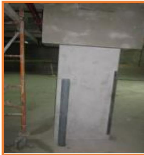
En la Figura I-12, la interferencia se da entre una tubería montante del sistema de desagüe y la columna, cuyo capitel no figuraba en el plano en planta de estructuras.
