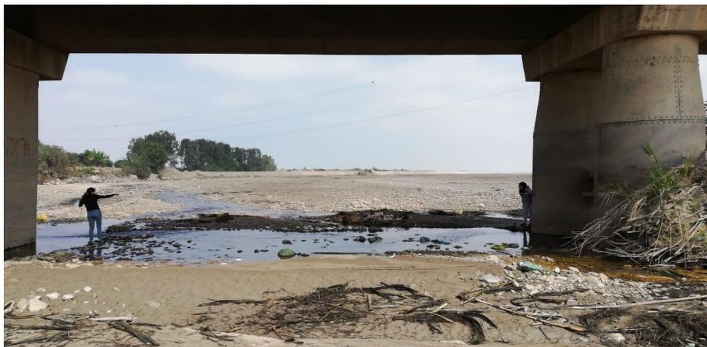
**Figura 37: Medición de la distancia entre pilares del puente Victoria**
