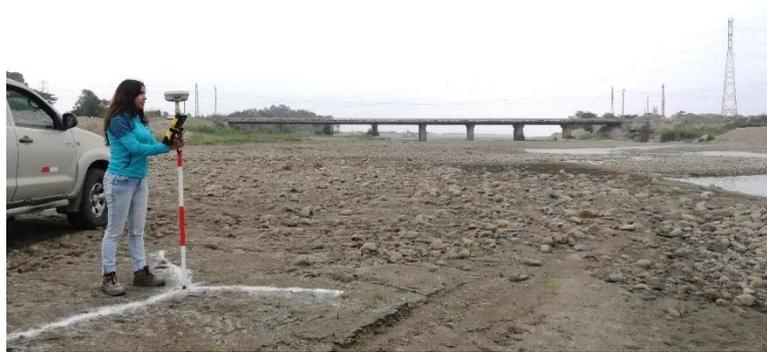
**Figura 14: Lectura de cota aguas arriba del puente Victoria.**
